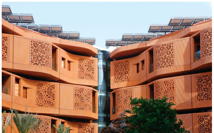
Fig.31 : représente la technique des façades utilisé dans l'institut (Source : http://www.constructionweekonline.com )
