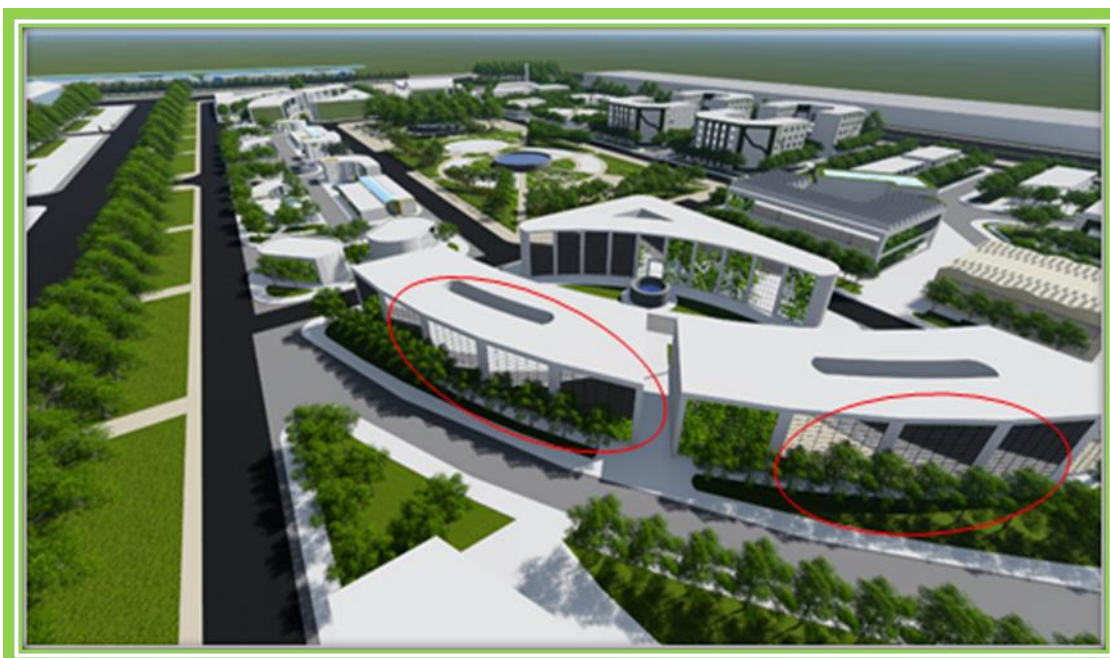
Fig 55: fenêtre à double vitrage
