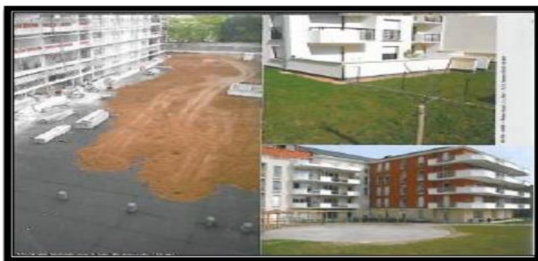
Fig 184 : Photo représente le toit stockant, Source : Guide de gestion des eaux de pluie et de ruissellement, 2006
