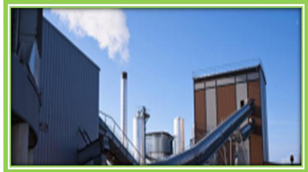
Fig 97 : usine pour l'énergie de la biomasse.
