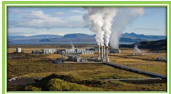
Fig 98 : centre de l'énergie géothermique
