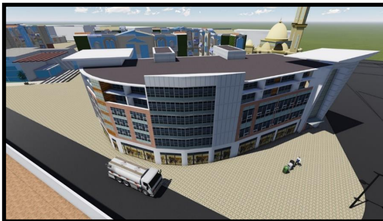
Photo 08: installation souterrain aspiration des déchets SOURCE : établir par l'auteur
