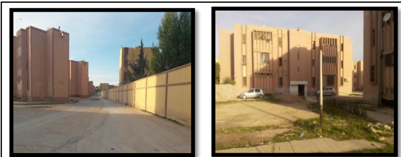
Photo 40.41 : Absence des mobiliers urbains. Source : pris par les auteurs
