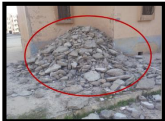
Photo 53: mauvais gestion de déchets de chantiers. Source : pris par les auteurs
