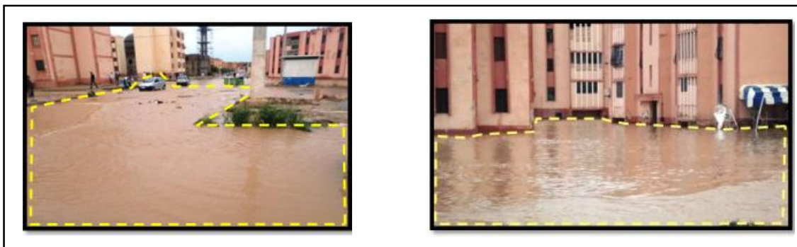
Photo 47.48 : Mauvaise d'états des réseaux hydraulique et des canaux de drainage de l'eau de pluie. Source : pris par les auteurs
