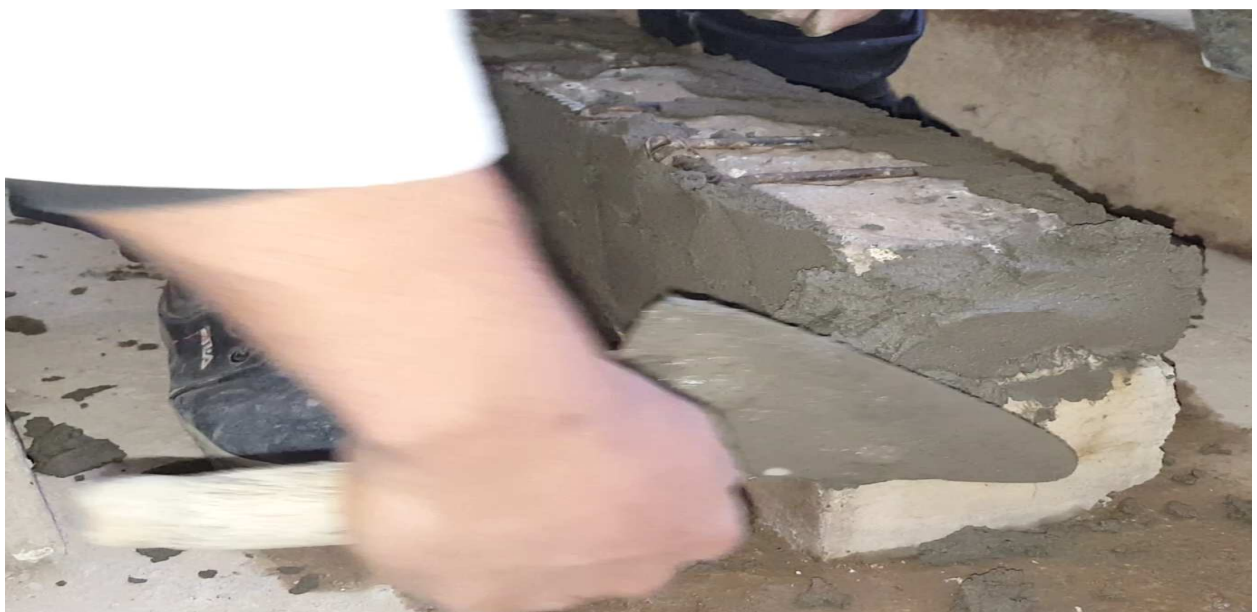
Photo 4 : L'application du mortier de réparation.
