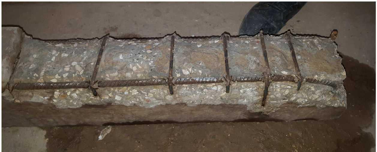
Photo 3 : L'humidification de zone à réparer.
