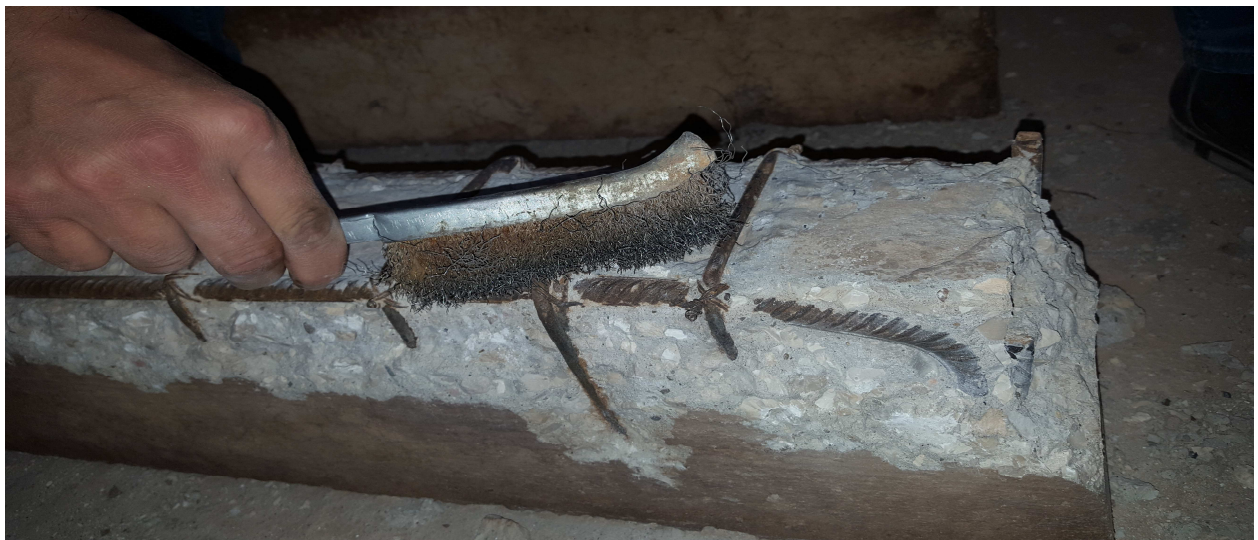
Photo 2 : Pansage des armatures corrodés
