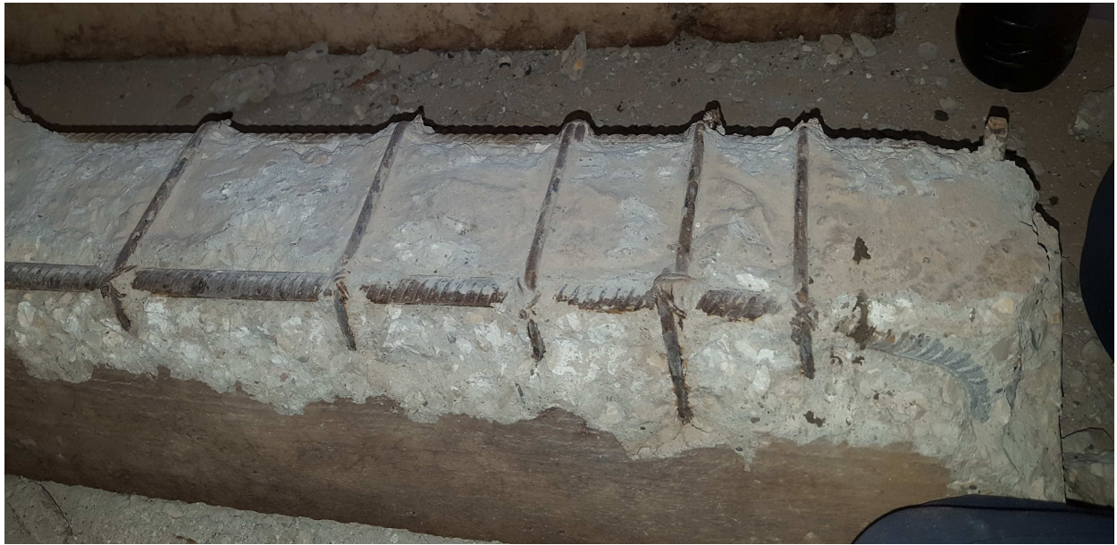
Photo 1 : Dégagement des armatures.
