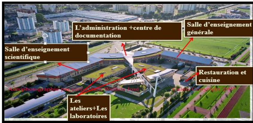
Figure 20 : les différents espaces de lycée
