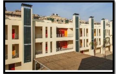
Photo 16 : les cheminées solaires
