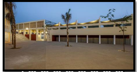
Photo 15 : la structure métallique
