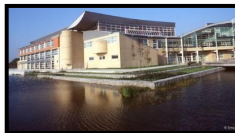
Photo27 : la récupération des eaux pluviales
