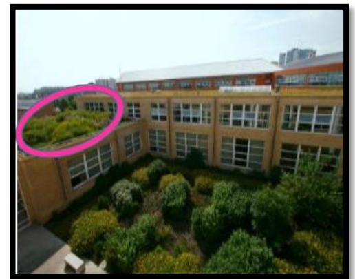
Photo31 : des terrasses végétalisées
