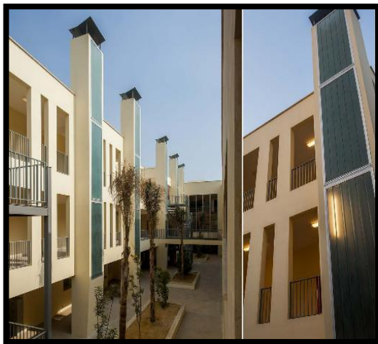
Photo 20 : Les cheminées solaires
