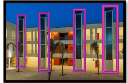
Photo 8 : Les cheminées solaires
