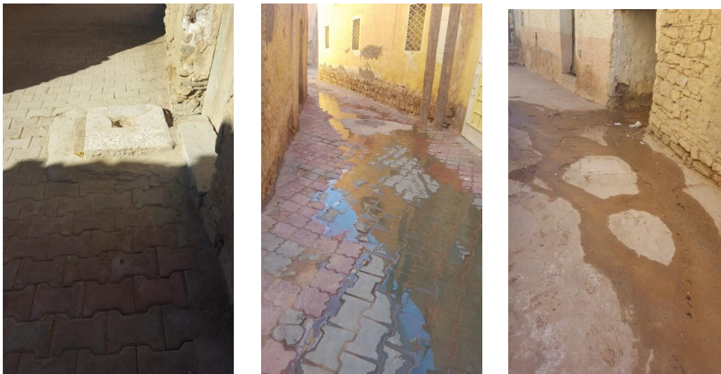
Photo II.33 : état de l'assainissement du ksar Source : (Laroui I et Chaoui L, 2017)
