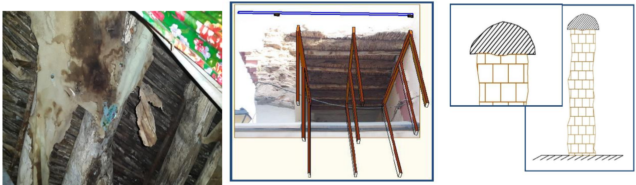
Figure II.53 : consolidation du plancher avec étaieiments en bois au niveau de l'espace d'ablution
