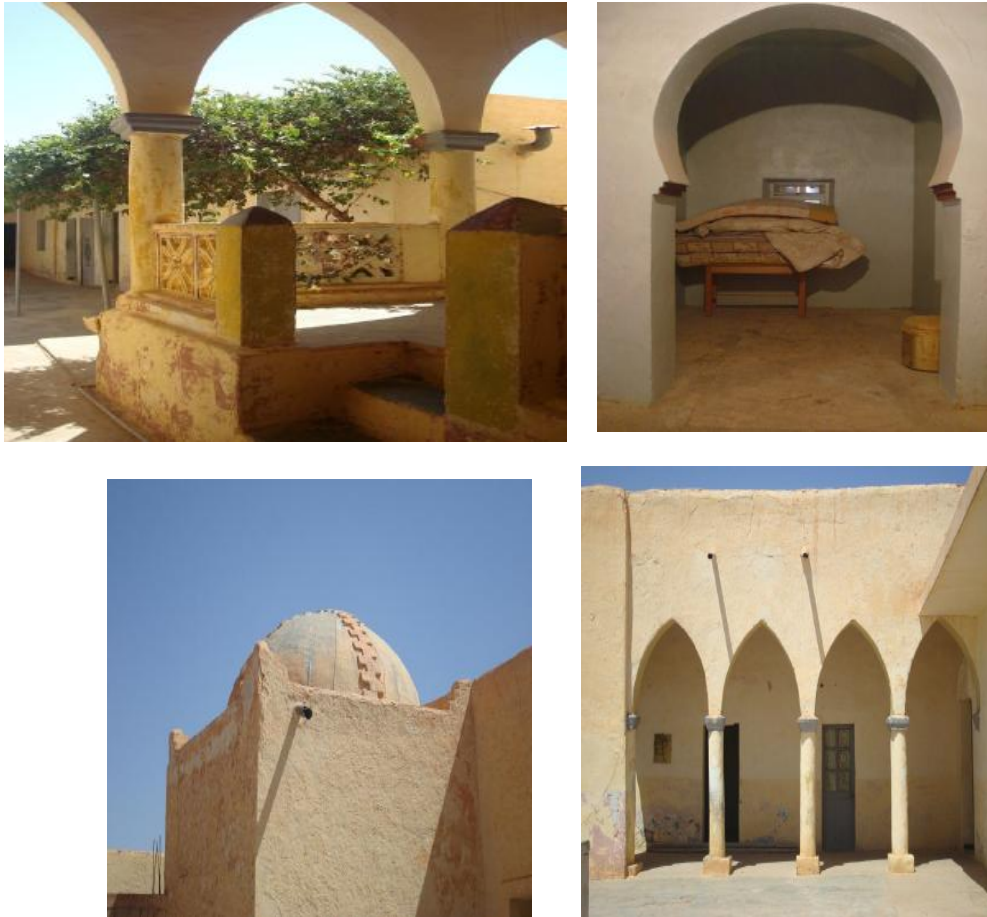
figure II.84: situation de la maison par rapport au ksar
