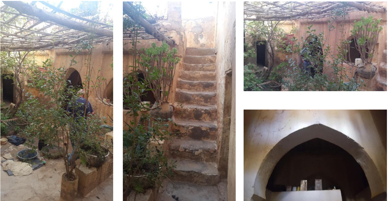
Photo II . 74: etat des lieux de la maison Abbou
