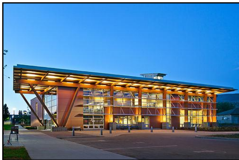
Figure 33 : La façade principale du projet [25]
