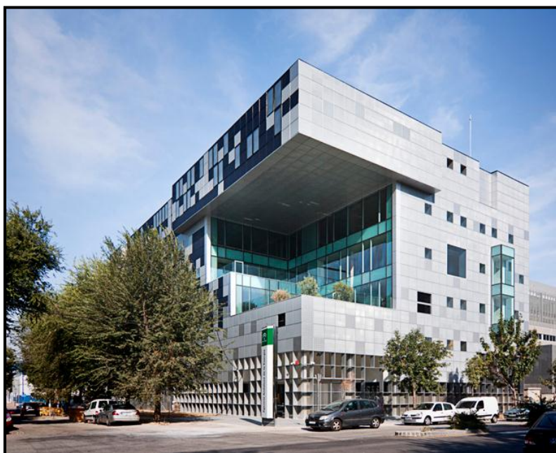
Figure 12 : Siège de l'agence andalouse de l'énergie (Espagne) [16]
