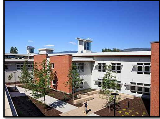
Figure 42 : Cheminées de ventilation [25]
