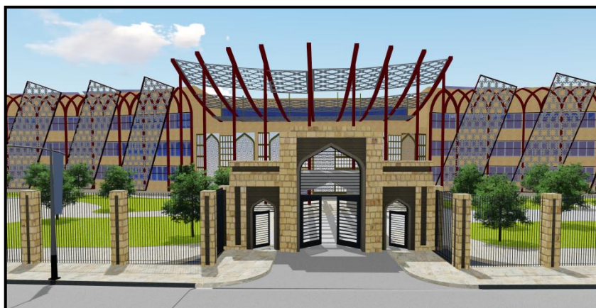
Figure 105 : Entrée principale du projet
