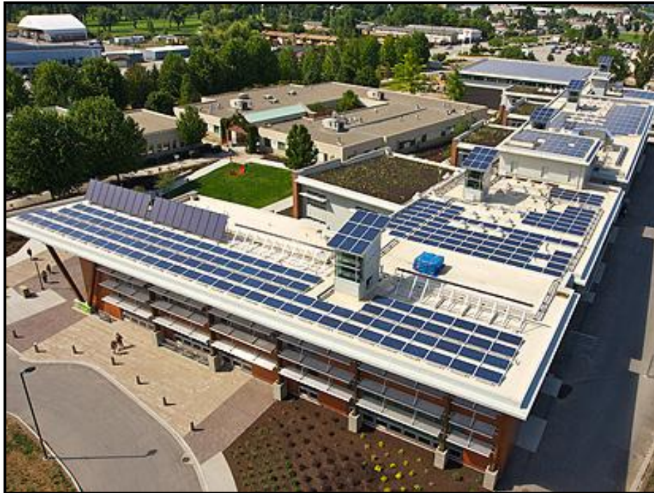
Figure 39 : Les panneaux photovoltaïques et la toiture jardin [25]
