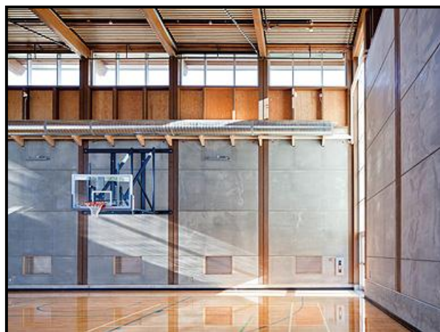
Figure 44 : Les panneaux muraux [25]
