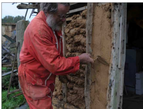
Photo I. 8 Construction d'un mur ( http://www.lesavoirfaire.fr/ )
