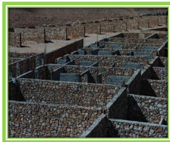
Figure 40: Construction des murs en pierre
