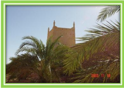
Figure 54: mur d'enceinte de k'sar Geurrara
