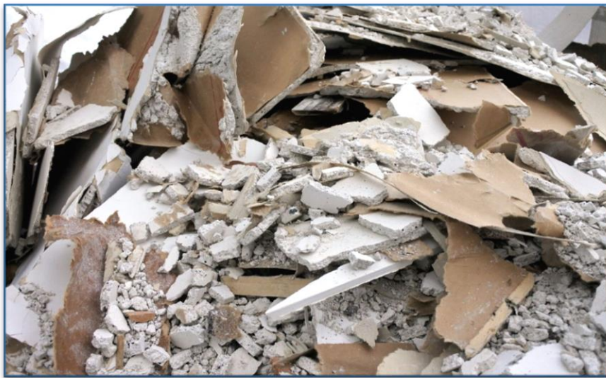
Figure I.5 : Déchet de plâtre récupéré [7]
