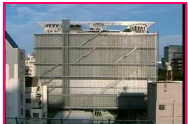
Figure 24:la façade ouest de la médiathèque de Sendai. Source : actuarchi.fr
