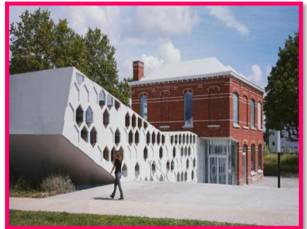
Figure 47: la vue extérieure de la médiathèque source: https://www.google.dz/maps 2016
