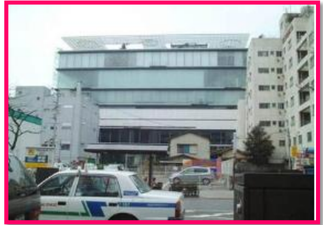
Figure 25: la façade nord de la médiathèque de Sendai. Source : actuarchi.fr
