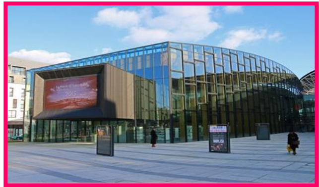
Figure 34:vue de La façade ouest de la médiathèque de Saint-Malo source : actuarchi.fr
