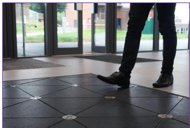
Figure 212 : La configuration de l'énergie cinétique par le revêtement de sol
