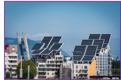
Figure 6 : Bâtiment Autonome en France Source : lemoniteur.fr
