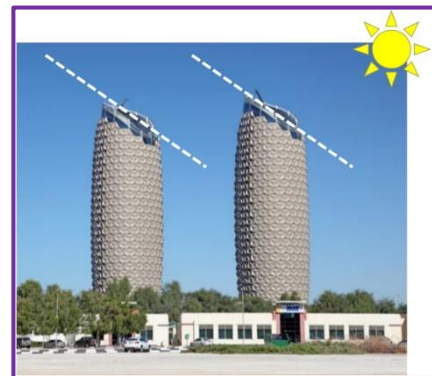
Figure 97 : Toit des tours
