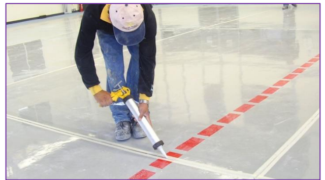
Figure 196 : Application du mastic sur les joints Source : bel.sika.com
