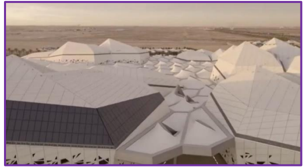
Figure 90 : Les panneaux photovoltaïques dans le projet
