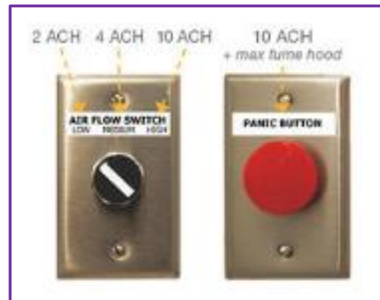
Figure 58 : système de contrôle de ventilation Source : www.aiatopten.org
