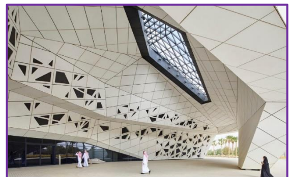
Figure 85 : Les panneaux GRC de la façade du projet Source : www.archidaily.com
