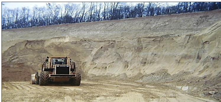
Figure I-4: Extraction du gypse à ciel ouvert [6].
