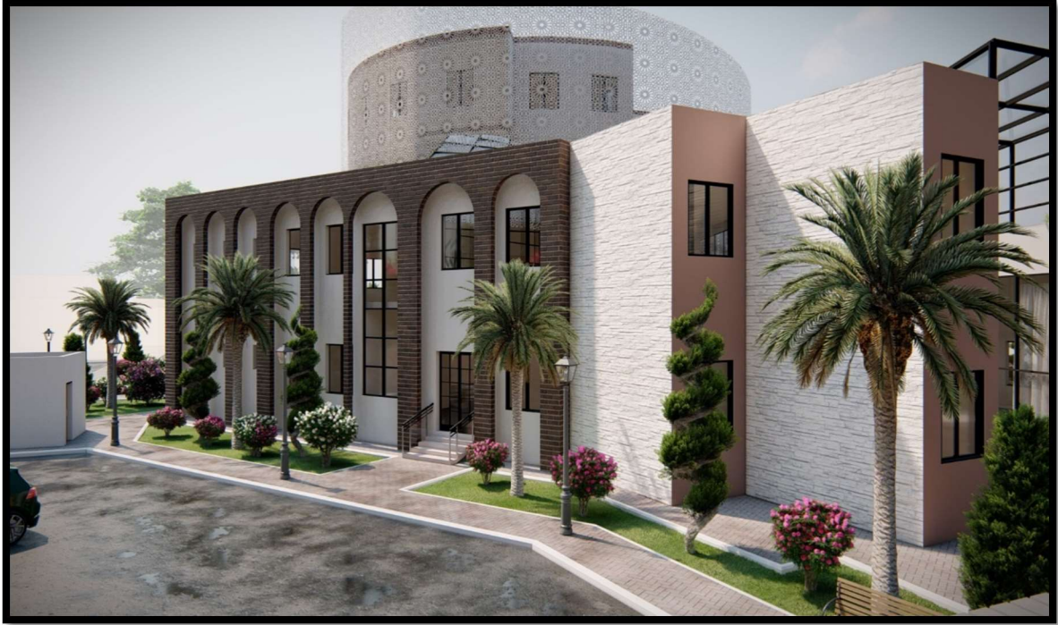
Figure124 : façade ouest /Source : Auteur
