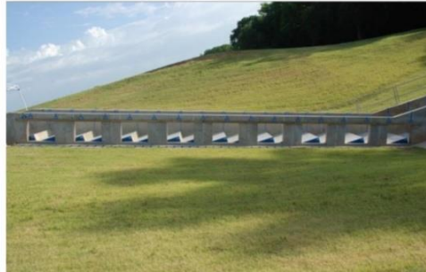
Photo 1.2 : Des expériences ont été menées sur ce modèle réduit d'une pente 14^\circ dans l'unité de recherche en génie hydraulique USDA-ARS de l'Université Stillwater, Oklahoma, États-Unis ( Hunt & Kadavy, 2016 )
