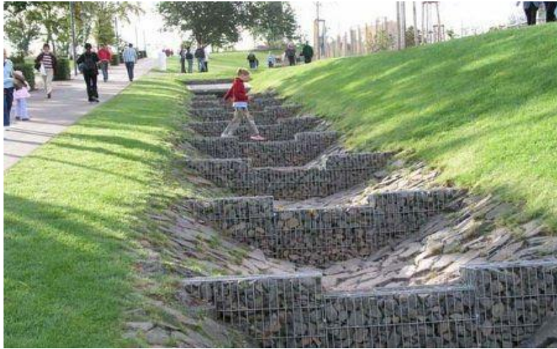
Photo 1.4 : Canal en marches d'escaliers en gabion ( https://www.pinterest.com/aero7507184/culvert-bridge-je/ )
