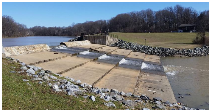
Photo 1.1: Déversoirs en marches d'escaliers du lac Wilde (Maryland, États-Unis) ( https://upload.wikimedia.org/wikipedia/commons/c/cc/Lake_Elkhorn_spillway_2016.jpg )
