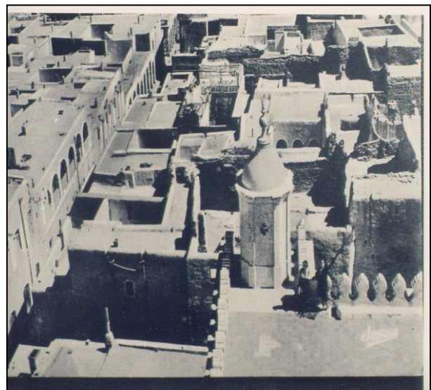
Figure III. 53 : L'ILOT BEN BOUTA SOURCE : ARCHIVE DE LAGHOUAT
