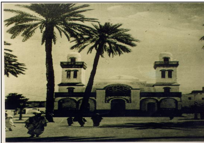
Figure III. 25 : EGLISE SAINT HILARION SOURCE : ARCHIVE DE LAGHOUAT
