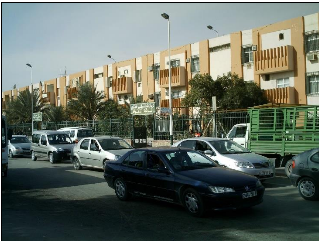
Figure III. 30 : MAAMOURA-ELGHAZALI SOURCE : AUTEURS
