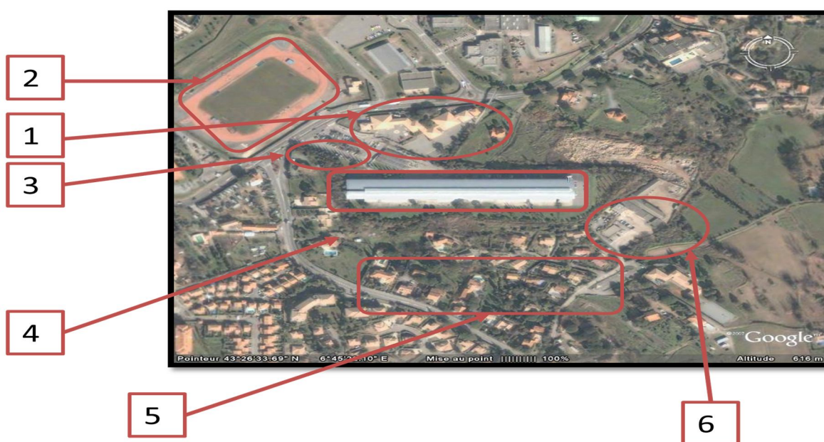
Figure12 : voisinage immédiat du lycée Albert camu .Source : http://www.fosterandpartners.com/projects/lycée-albert-camus/ consulté: janvier2015
