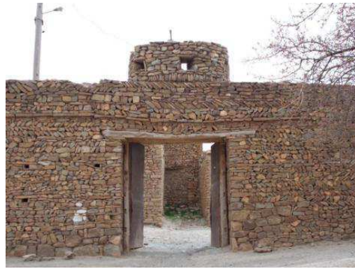
Fig 36 : La nouvelle porte du ksar de Taouiala [24]
