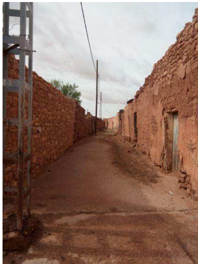
Fig33 : Le pavé en béton au ksar Source : (auteure)
