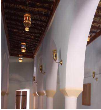
Fig31 : Vue à l'intérieure de la mosquée du ksar Source : (auteures)
