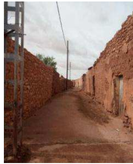
Fig72 : Vue sur la rue secondaire
