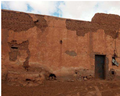
Fig49 : Vue sur une dokana demi-circulaire du ksar Source : (auteures)
