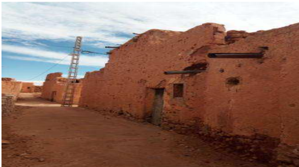
Fig64 : Façade (1) d'une maison avant le ravalement Source : (auteure)
