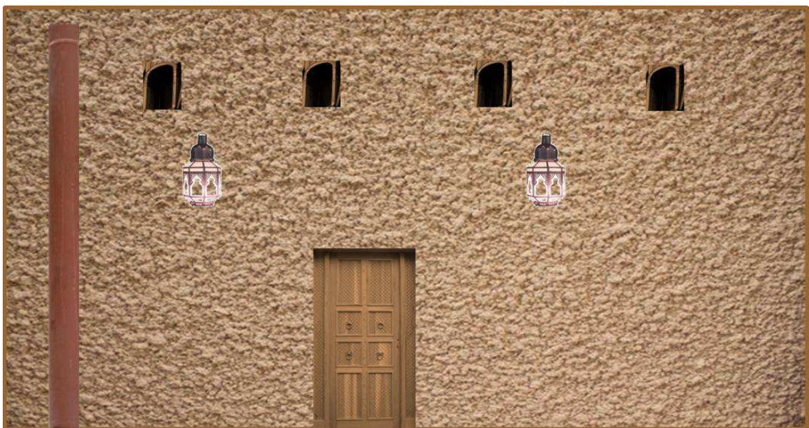
Fig69 : Façade (2) d'une maison après le ravalement Source : (auteur)
