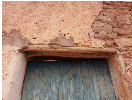
Fig60 : Exemple d'un linteau en genévrier Source : (auteures)
