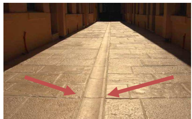
Fig37 : Système de drainage des eaux Source : (auteur)
