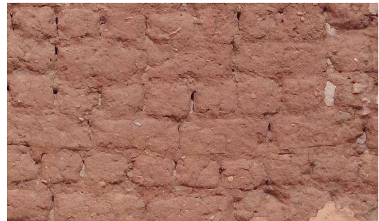
Fig53 : Appareillage en pose panneresse Source : (auteures)
