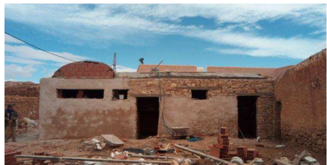
Fig35 : Vue sur le hammam du ksar - photo de travaux de reconstruction actuelle- Source : (auteures)
