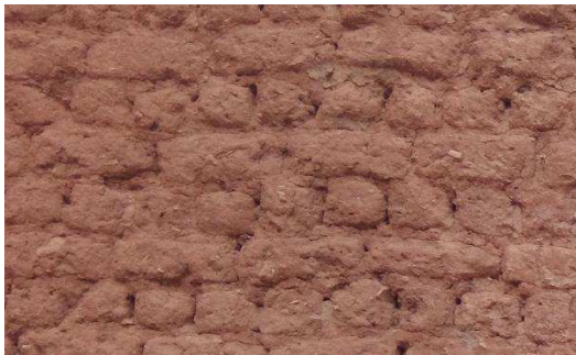
Fig52 : Appareillage en pose boutisse Source : (auteures)
