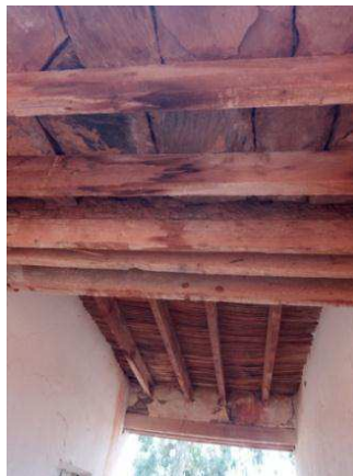
Fig57 : Le plancher de la porte d'est Source : (auteures)
