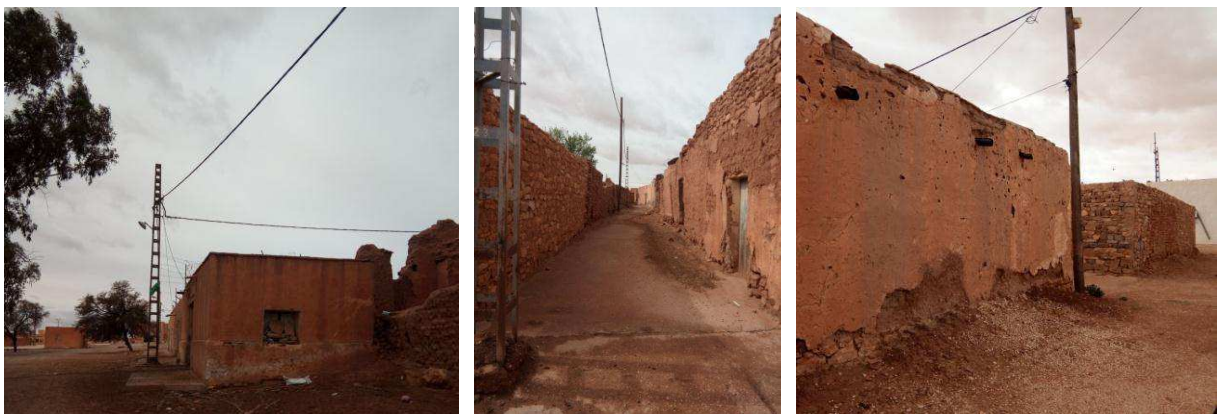
Fig52 : Les postes de transformation au niveau de ksar Source : (auteure)
