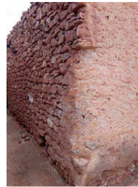
Fig30 : Angle tronqué d'un mur
