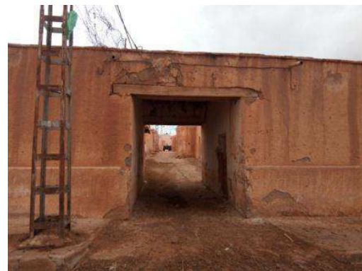
Fig27 : Vue sur l'entrée d'est du ksar Source : (auteures)
