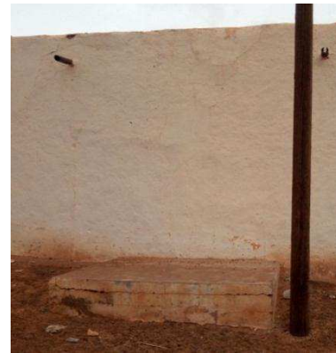
Fig50 : Vue sur une dokana carrée du ksar Source : (auteures)
