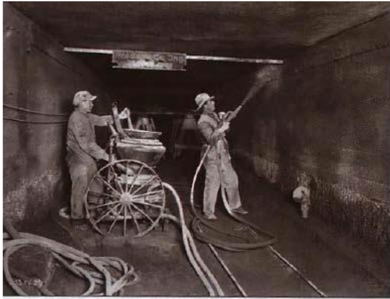
Figure IV.16. Le béton projeté
