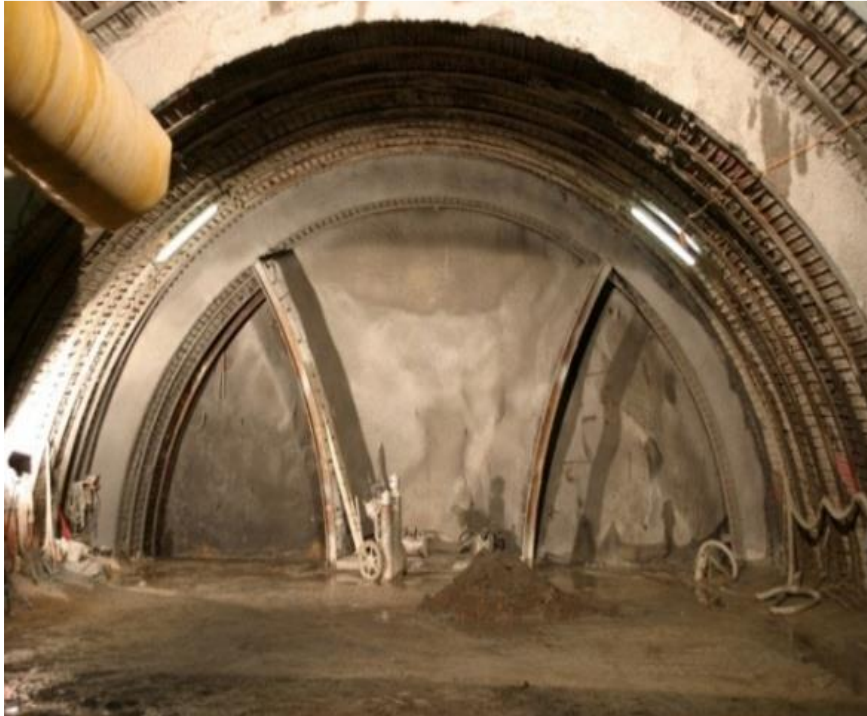
Figure IV.7 Creusement de la section divisée
