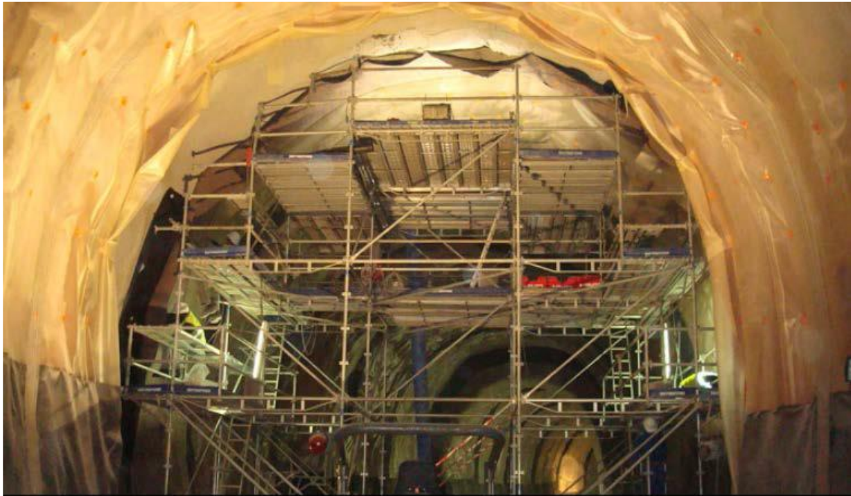
Figure IV.24 : Étanchement par feuille [29]
