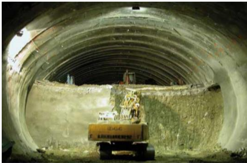
Figure IV.6 Creusement en demi-section
