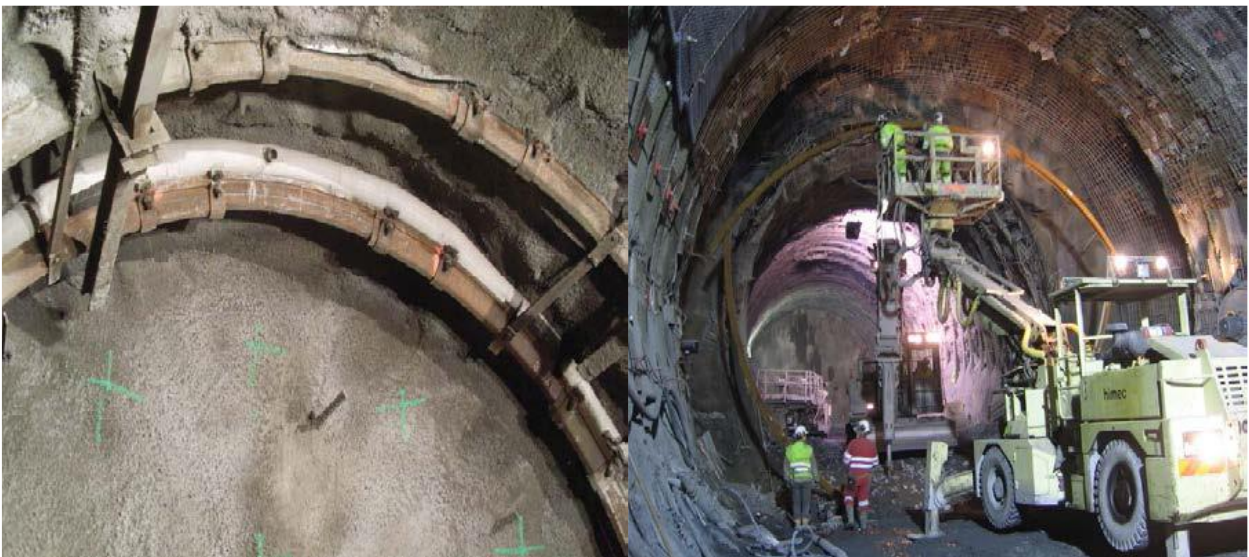
Figure IV.19 Cintres TH, boulons radiaux et béton projeté. Détail de la voûte d'une galerie du laboratoire souterrain de l'Andra
