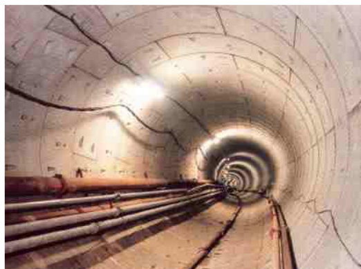
Figure IV.25 : Voussoirs en béton [22]
