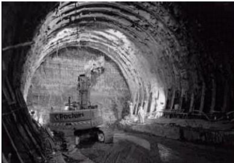
Figure IV.5 Creusement à pleine section
