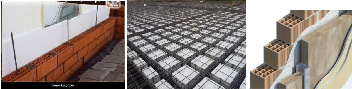
الصور رقم (102-103-104) - توضح كيفية مختلف مواد البناء المستعملة في المساكن
