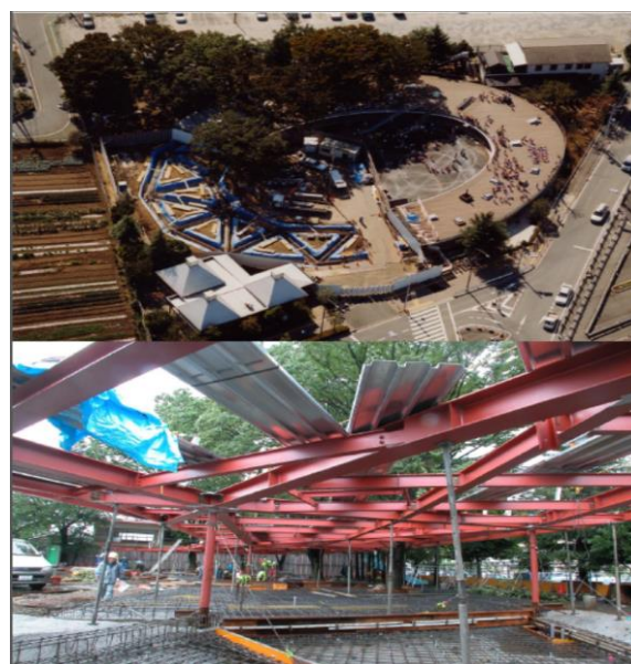
Figure 58: système constructif en charpente métallique
