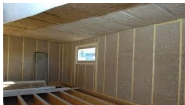
Figure 161 : isolation acoustique et thermique d'un maison avec la palle
