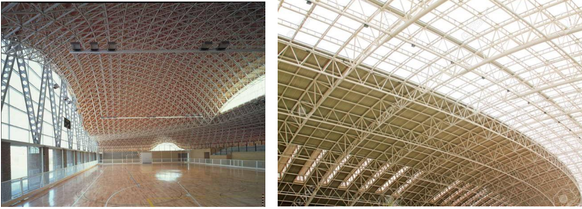
Figure 140 : Charpente métallique Treillis d'un stade ou chine
