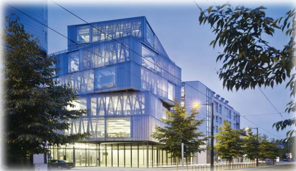
Figure I-36 : La peau semi-transparente de l'École d'architecture de Strasbourg
