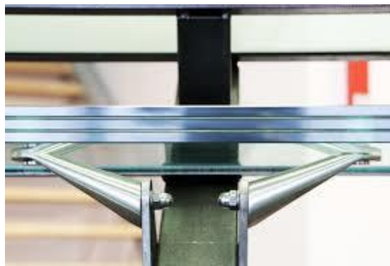
Figure V-14 : fixation de l'atrium
