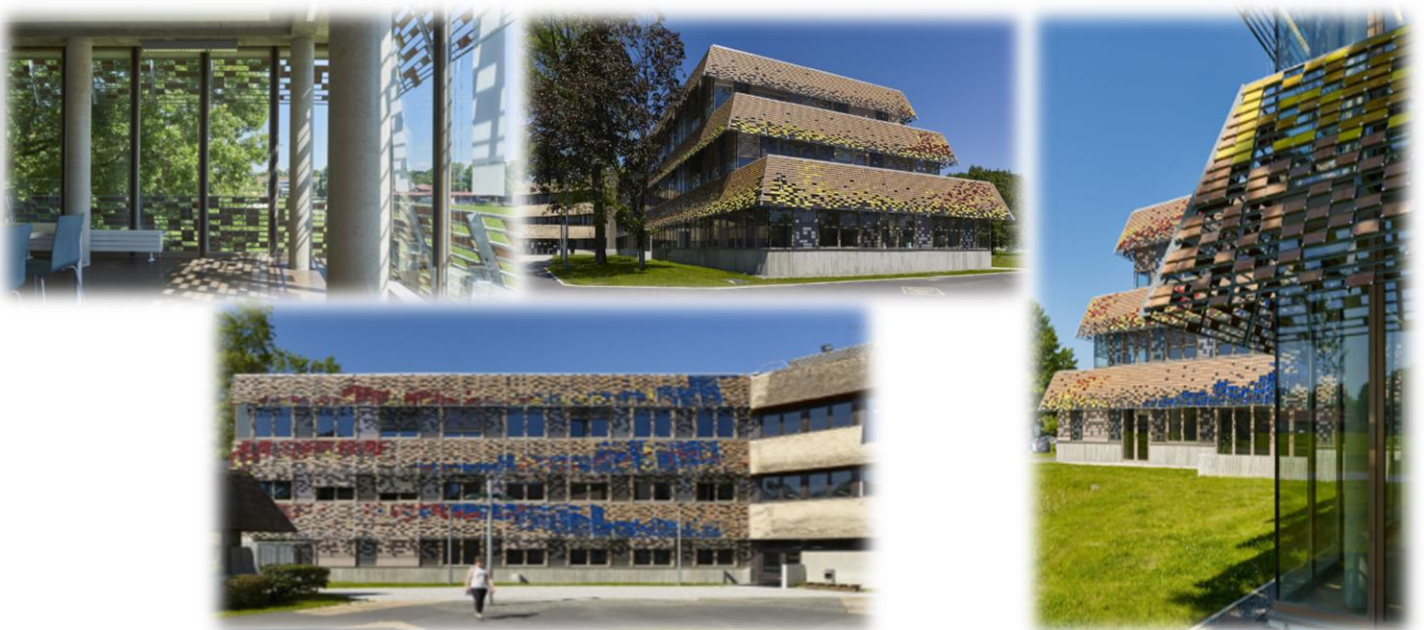
Figure I-63 : Façade de l'Université de Pau et des Pays de l'Adour
