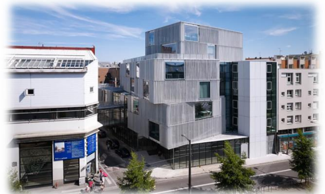
Figure I-32 : Façade de l'École d'architecture de Strasbourg
