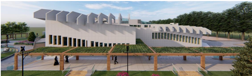
Figure V-7 : protection solaire avec végétation et percolas
