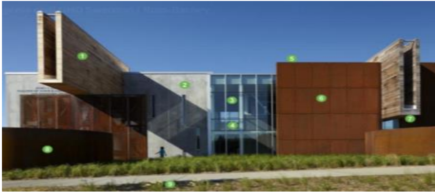
Figure I-76 : les matériaux de construction de l'Université de Swenson Civil Engineering Building
