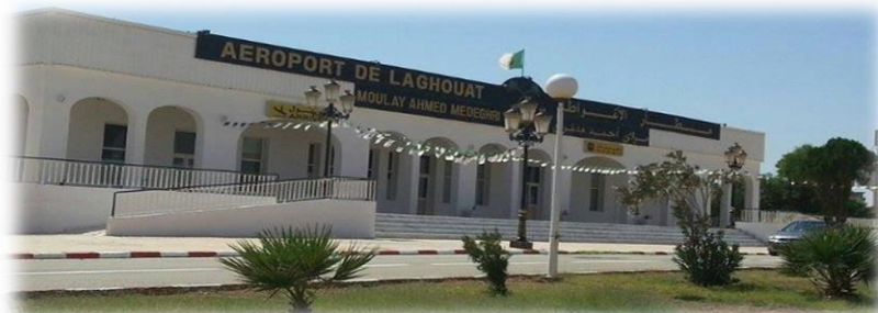
Figure II- 2 : aéroport de la ville de Laghouat.
