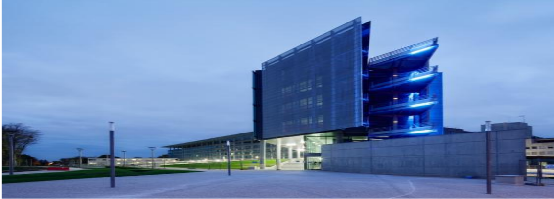
Figure 32: Entrée vers le hall d'accueil, angle sud- est
