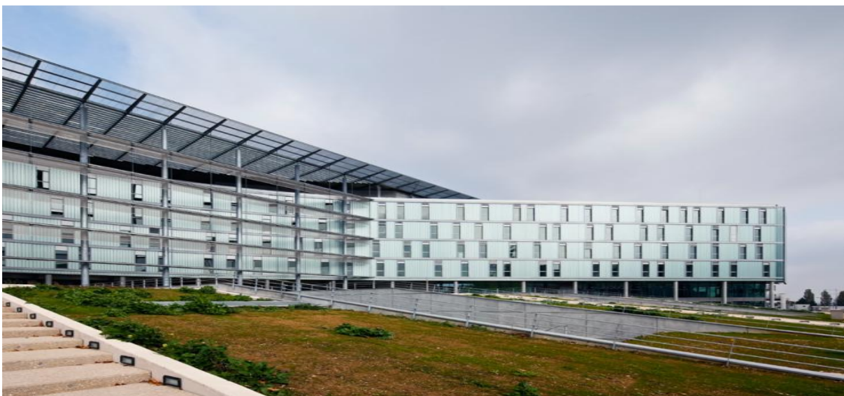
Figure 34 : Façade sud, longue courbe sur 200m
