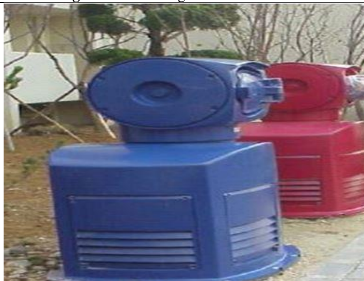
Figure 52: Système fixé aspiration par réseau souterrain
