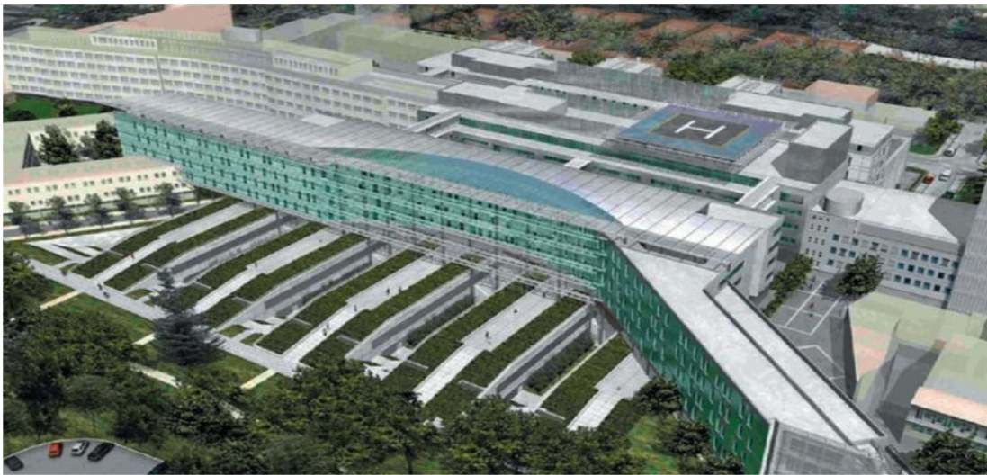
Figure 31: Bocage centrale du CHU DIJON
