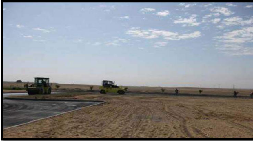
Figure 05 : démarrage des travaux des infrastructures de la ville nouvelle de Boughezoul.
