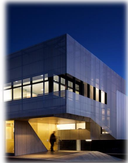
Figure II. 1 : vue sur l'entrée principale de l'immeuble bureau sanwell source : architectureanddesign.com
