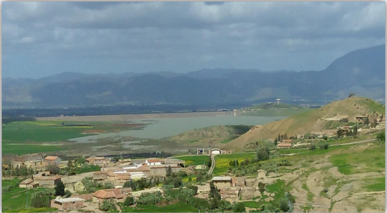
Photo 1: Photo d'un vue générale du Barrage de Harreza ( Cliché Bettassa et Tafiani 2018 )
