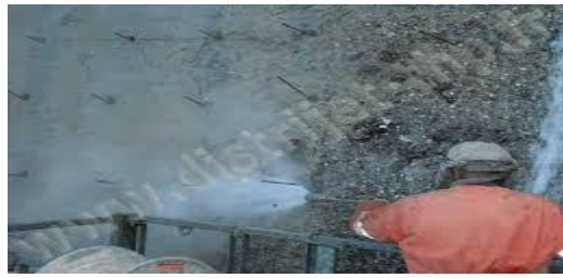
Figure II.17. Sablage au jet. [9]
