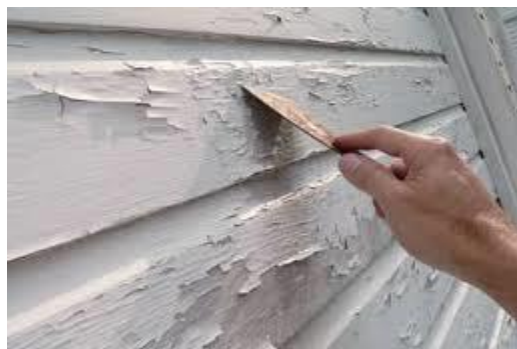
Figure II.15. Décapage chimique. [9]
