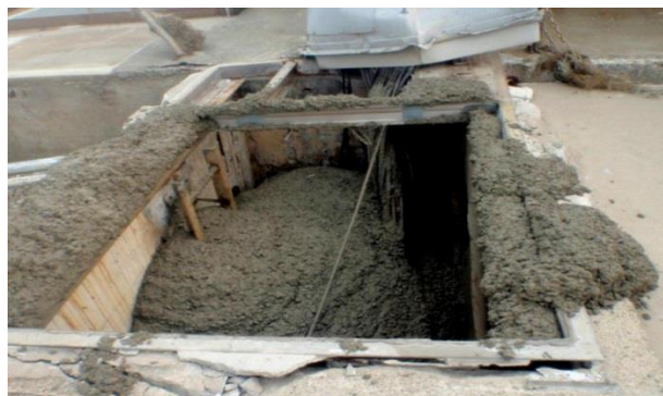
Figure I.2.Effondrement des coffrages
