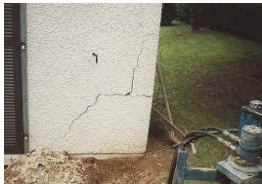
Figure I .10. Les tassements
