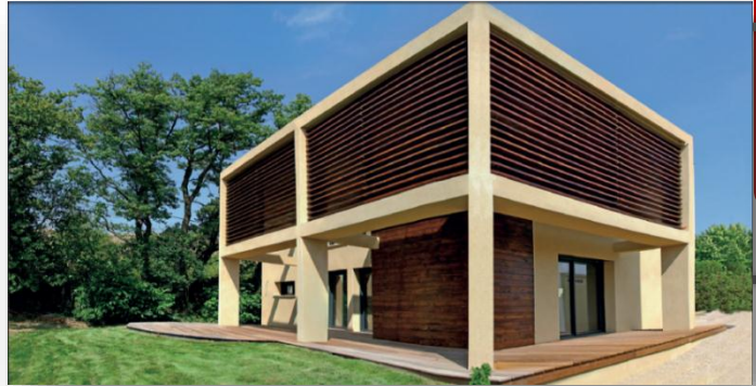
Figure I.3 : Vue extérieure sur la maison RESPEKT. source : http://www.maison-respekt.fr/
