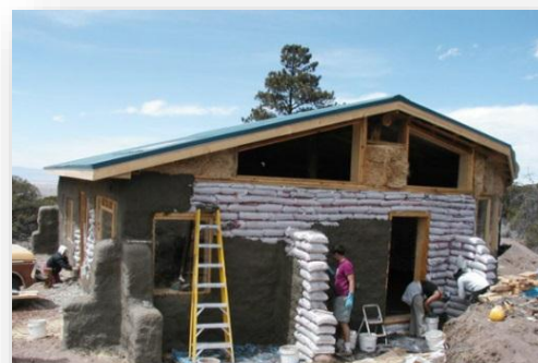
Figure I.43 la mise en œuvre d'une maison en sacs de terre. Source : memoireonline.com/
