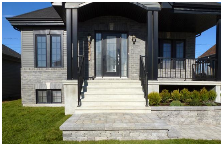
Figure IV.1 : porte d'entrée principale. Source : www.maison-deco.com
