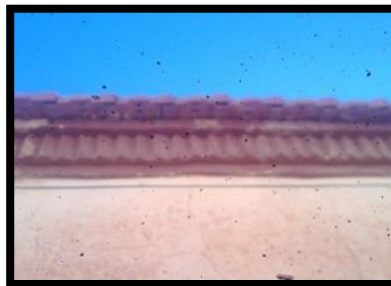
Figure 110: l'ornementation d'une maison. Source : auteurs. Le :26/12/2018
