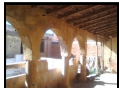
Figure 97: la galerie. Source : auteurs.
