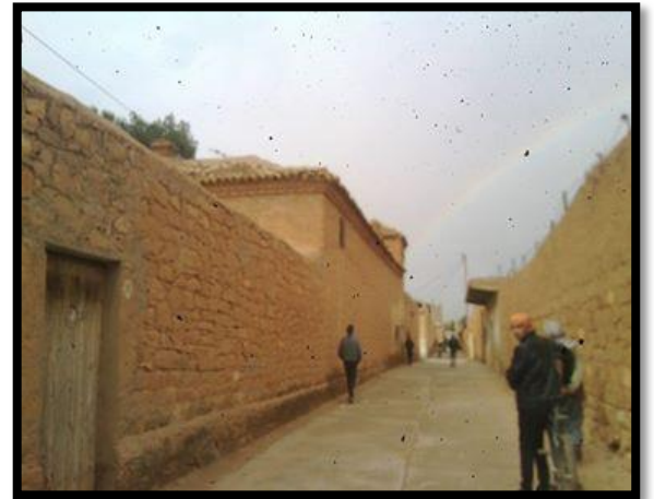
Figure 84: vue sur le noyau. Source : auteurs. Le : 26/12/2018
