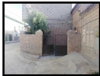
Figure 104: entrée d'une maison dans le Ksar. Source : auteurs. Le :26/12/2018
