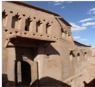
Photo 12: Le même bâtiment Terminé. Le béton est masqué sous les enduits.
