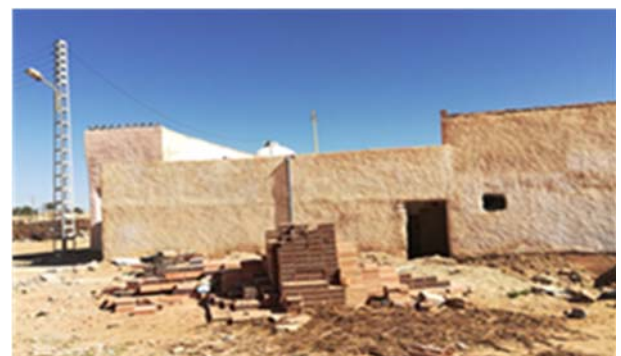
Photo 52: Façade latérale de la mosquée de Tadjrouna.
