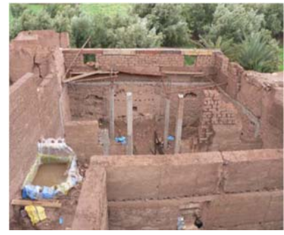
Photo 13: Reconstruction d'un bâtiment à partir d'une ruine avec insertion de chaînages et d'une.
