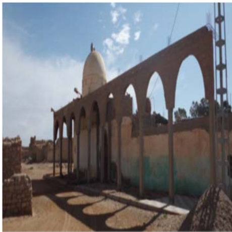
Photo 49: Façade principale de mosquée de Tadjrouna avant l'intervention.
