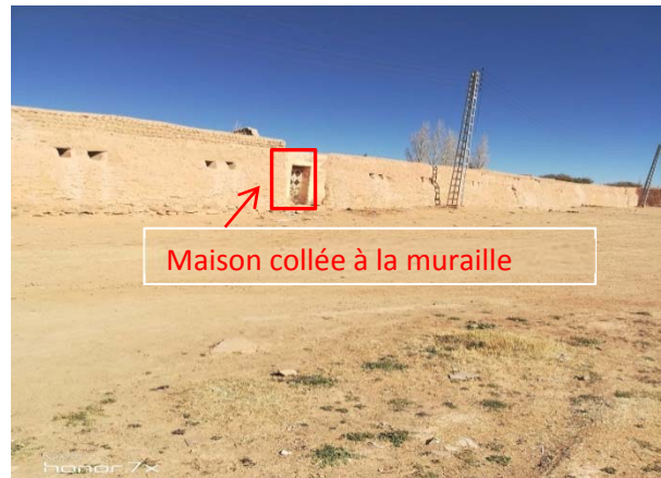
Photo 42 : muraille vers l'extension de ville.
