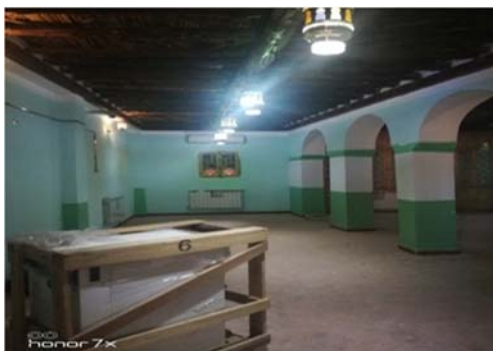
Photo 51: La mosquée à l'intérieur après l'intervention 2018.
