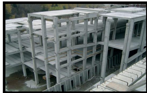
Figure 38 .V : structure préfabriquée Source : http://www.batimentsindustriels.be
