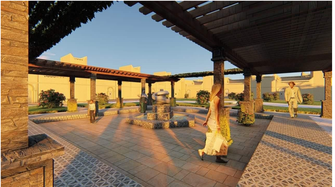
Figure 84: vue sur entité rénovation (la place)
