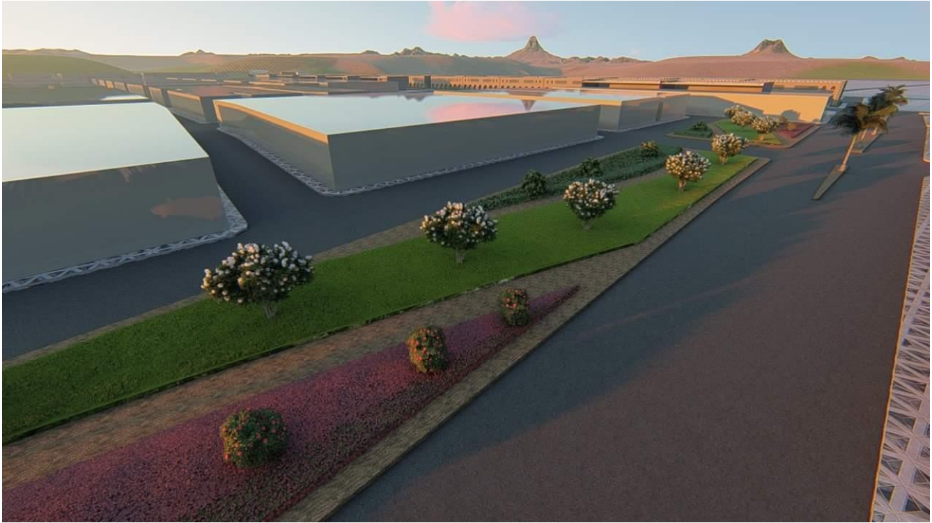
Figure 90: vue sur les voies 1(élargissement des voies)
