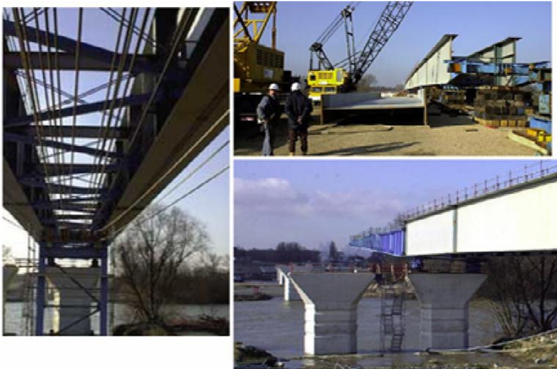
Figure. I.11 : l'opération de lancement
