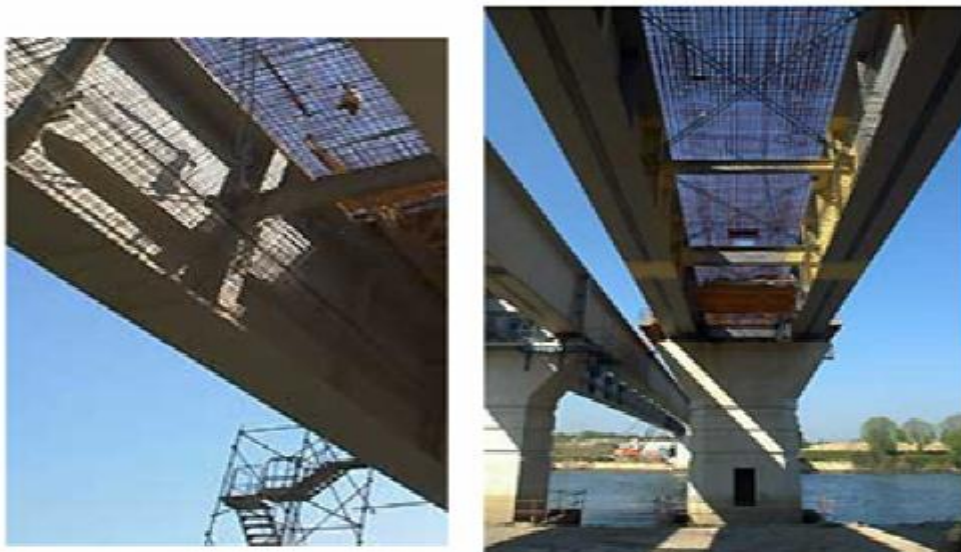
Figure. I.12 : La pose en place des armatures
