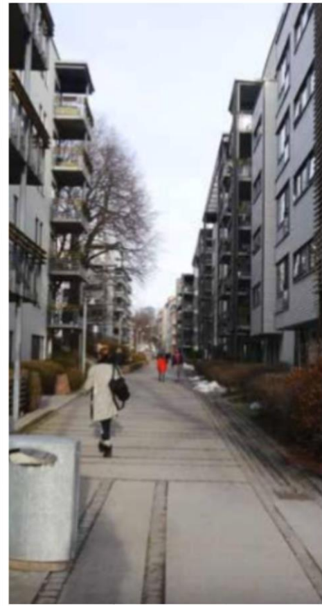
صورة 02: صورة توضح المسافة بين بعض المباني
