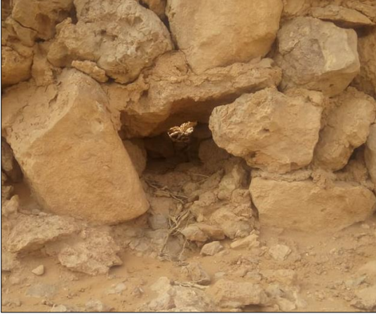
Figure 24 صورة تبين فتحات تصريف الامطار (تعمل بشكل عادي) المصدر : الباحث بتاريخ 2022-02-19
