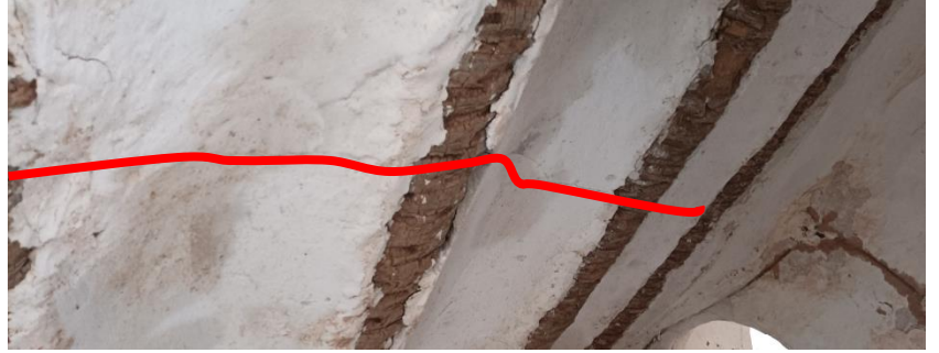
صورة توضح مختلف التشققات التي أصابت المسكن - من اعداد
