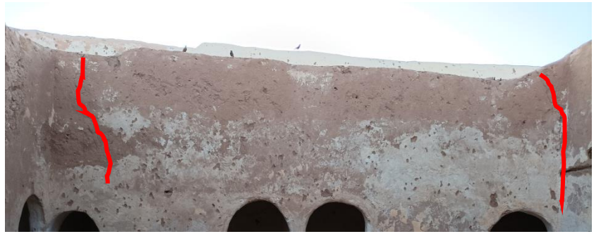
صورة توضح مختلف التشققات التي أصابت المسكن - من اعداد
