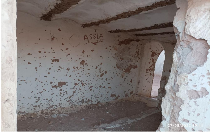
صورة توضح تآكل التلبس الخاص بالمسكن - من اعداد الطالب
