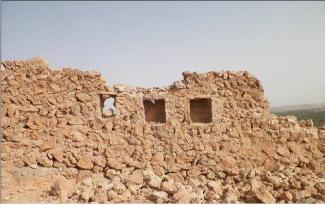
Figure 12 صورة أجزاء من المساكن منهارة في القصر المصدر : الباحث بتاريخ 2022-02-19
