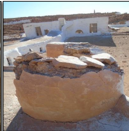
صورة 44 انهيار كلي لسقف السلالم على مستوى السطح. (الطالب)
