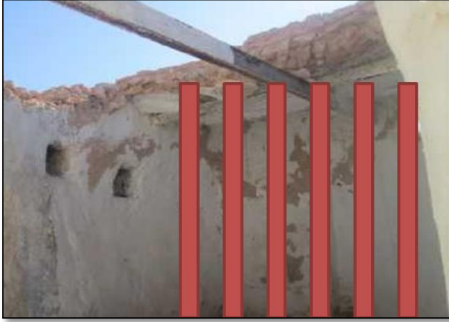
صورة 89 أعمال الطوارئ الخاصة بسقف مصلى بابا والجمة (المصدر الطالب)
