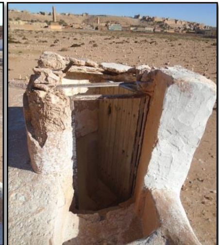
صورة 44 انهيار كلي لسقف السلالم على مستوى السطح. (الطالب)
