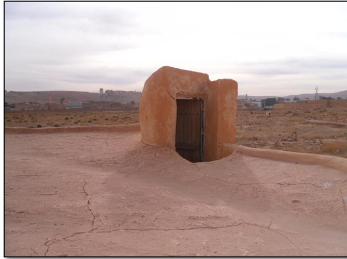
صورة 94 تبين التشققات على مستوى السطح المصليات (المصدر الطاب).
