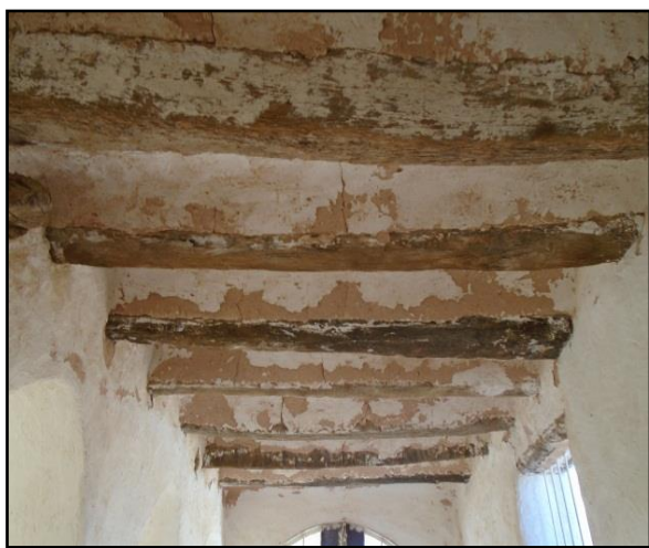
صورة 53 تفتت ملاط السقف (الطالب)
