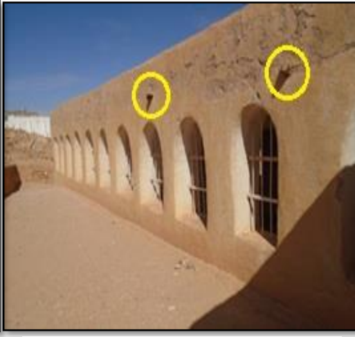
صورة 55 ظهور جدوع النخل وتفتت ملاط الجير على مستوى الجدران الخارجية (الطالب)
