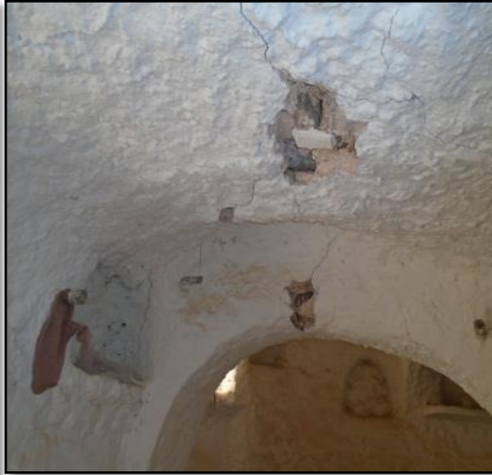
صورة 69 تشققات كبيرة على مستوى السقف (القبب) (الطالب)
