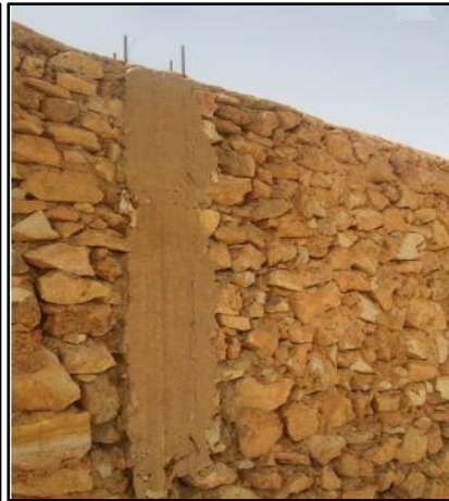
صورة 77 استعمال الخرسانة المسلحة، واجهة غير ملبسة، تدهور الميزاب (الطالب)
