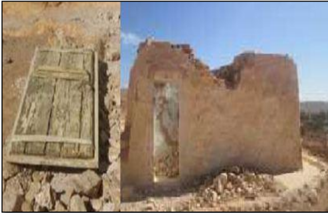
صورة 58 انهيار جزئي للجدار الحامل، قلع كلي لباب المصلى (الطالب)
