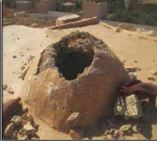
صورة 60 انهيار جزئي للقبعة على مستوى السطح (الطالب)
