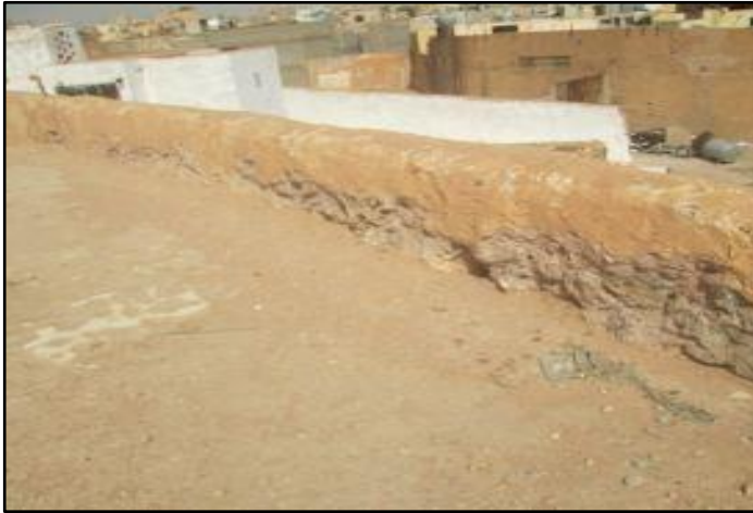
صورة 75 تآكل وتفتت الجزء السفلي من جدار المحضرة (الطالب)
