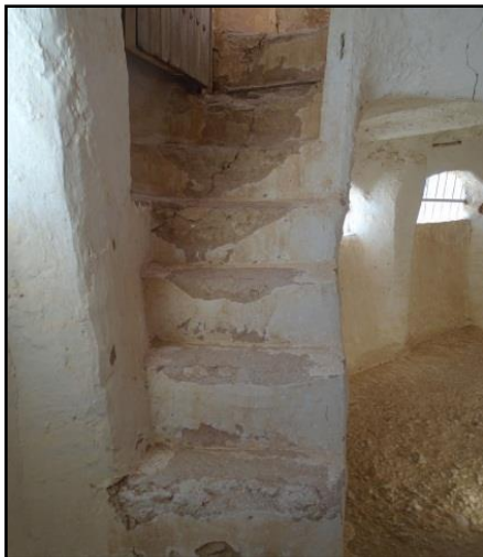
صورة 43 انهيار بعض أجزاء السلالم الطابق الأرضي (الطالب)
