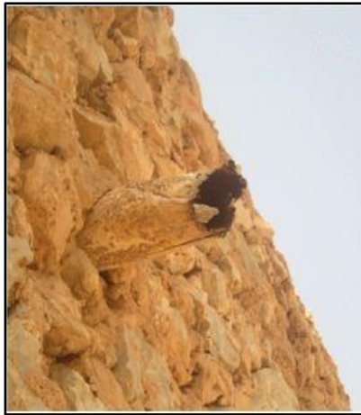
صورة 77 استعمال الخرسانة المسلحة، واجهة غير ملبسة، تدهور الميزاب (الطالب)
