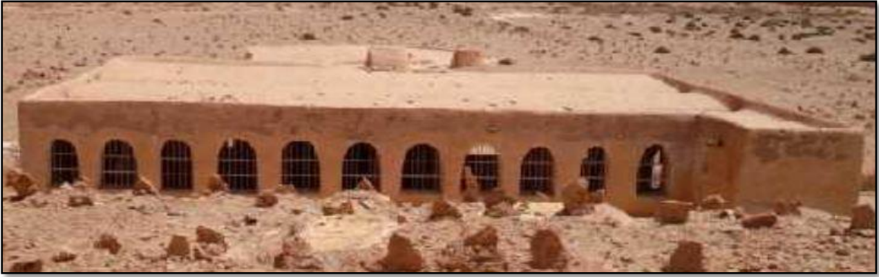
صورة 19 الواجهة الجنوبية لمصلى عمي سعيد (المصدر الطالب)
