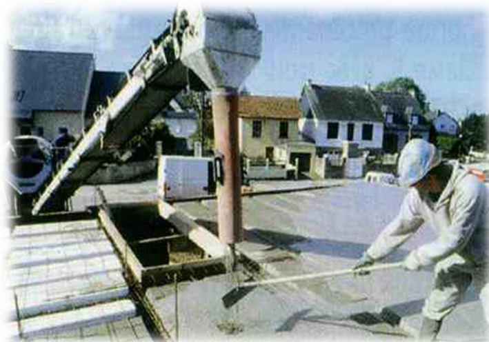
Figure 0-1 - Mise en place du BAP par un seul ouvrier.
