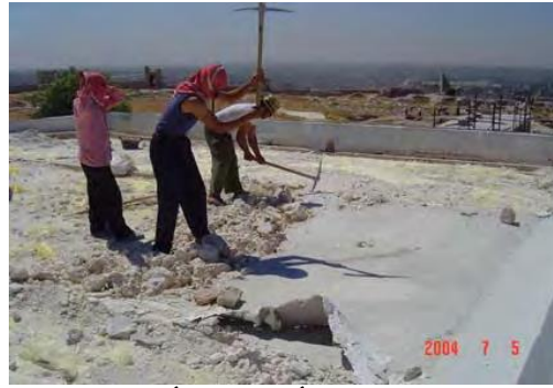
صورة 17: أعمال الأسقف
