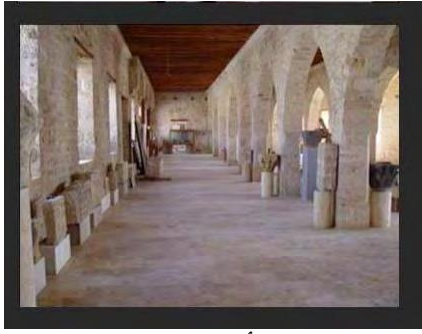
صورة 16: الأعمدة الداخلية للثكنة بعد الترميم
