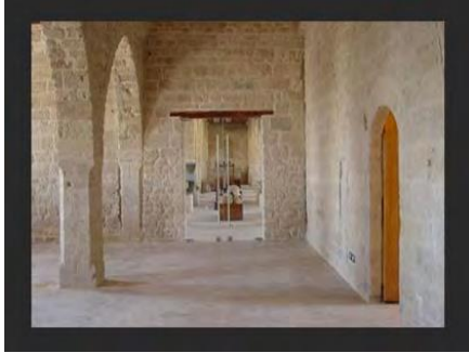
صورة 14 : الكافتيريا بعد أعمال الترميم
