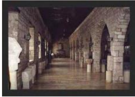
صورة 15: الأعمدة الداخلية للثكنة قبل الترميم
