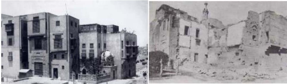
صورة 06 : تمثل بيت الكريدلية بعد إعادة البناء المصدر : لجنة حفظ الآثار العربية
