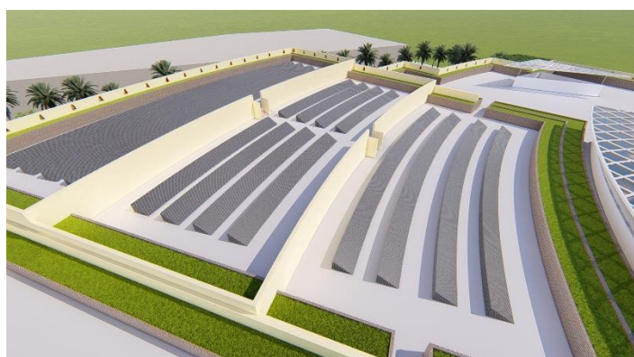
Figure 140 : Panneaux Photovoltaïques Intégrant Au Toiture Source : Auteurs
