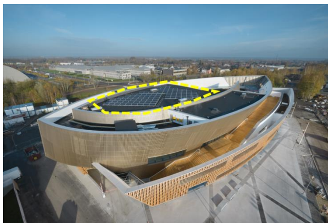
Figure 30 : L'Intégration des Panneaux Photovoltaïques au Terrasse
