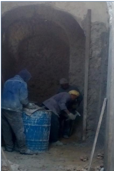
الصورة 15. الربقلة المستعملة في البناء بالحي العتيق الاعشاش المصاعبة بالوادي
