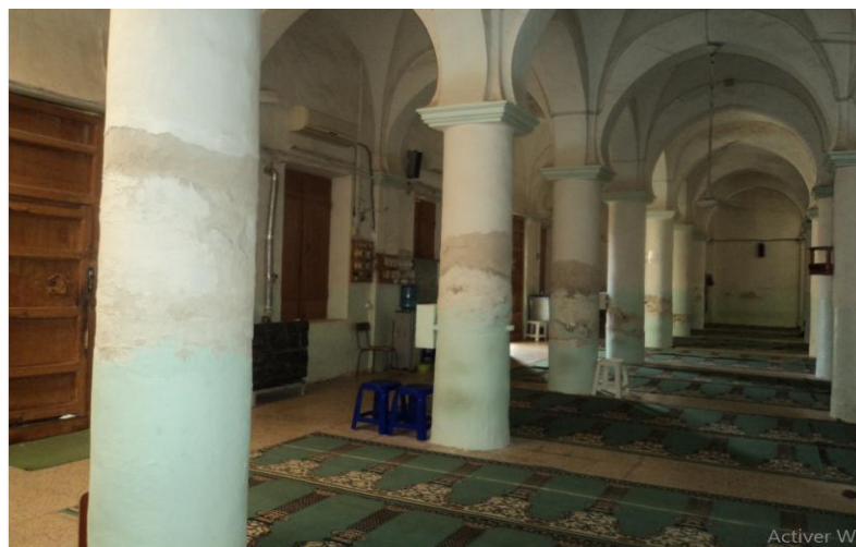
صورة 29 : تظهر تأثير الرطوبة على الاعمدة داخل قاعة الصلاة
