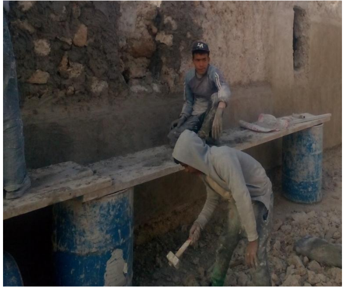
الصورة 19. طريقة استعمال السريـر في البناء بالحي العتيق الاعشاش المصاعبة بالوادي
