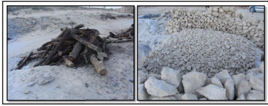
الشكل 1. طريقة تحضير الجبس التقليدي المستعمل في البناء بالحي العتيق الاعشاش
