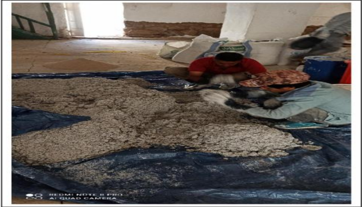
صورة 22: تحضير مواد البناء لترميم المبنى.
