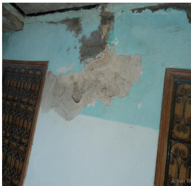
صورة 22 : تظهر تأثير الرطوبة على الجدران و السقف و تأكلها
