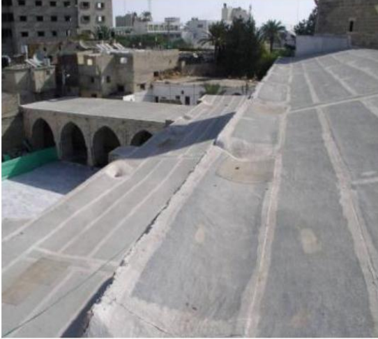
صورة 40: إزالة طبقات العزل على سقف المسجد. صورة 41: ألواح البيتومين المستخدمة في عزل السقف.
