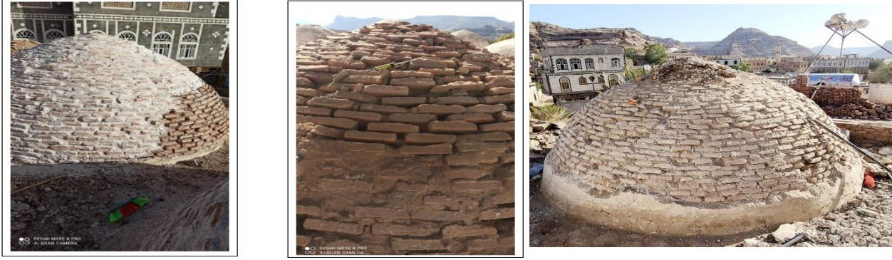
صورة 23: مراحل مختلفة لترميم طبقات القبة.
