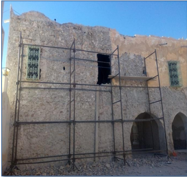
الصورة 19. طريقة استعمال السريـر في البناء بالحي العتيق الاعشاش المصاعبة بالوادي
