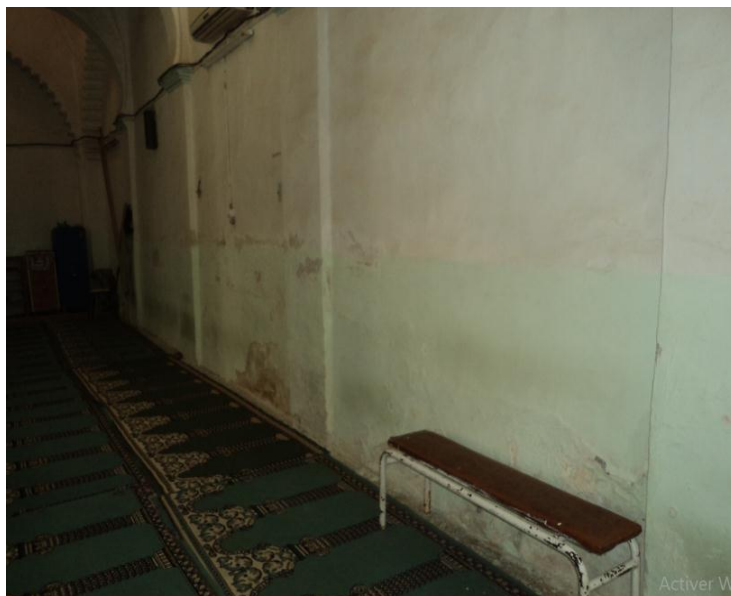
صورة 32 : تظهر تأثير الرطوبة على مستوى الجدار الخلفي لقاعة الصلاة
