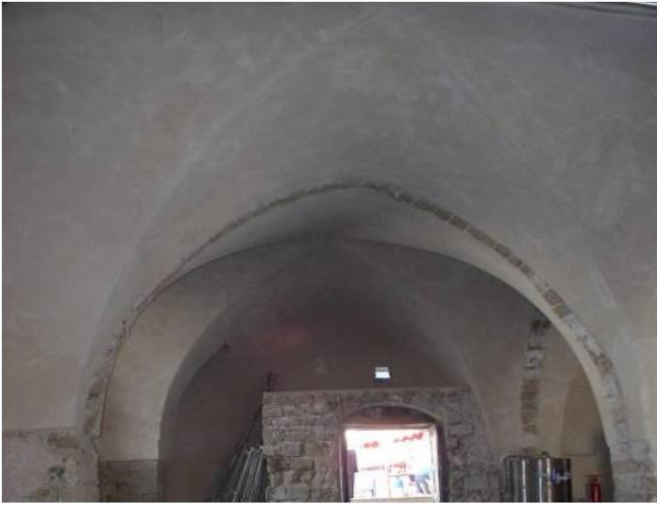
صورة 43: تعبئة الشقوق بالمونة التي تحتوي على قطع الفخار. صورة 44: طبقة القسارة التي تحتوي على الكركار.
