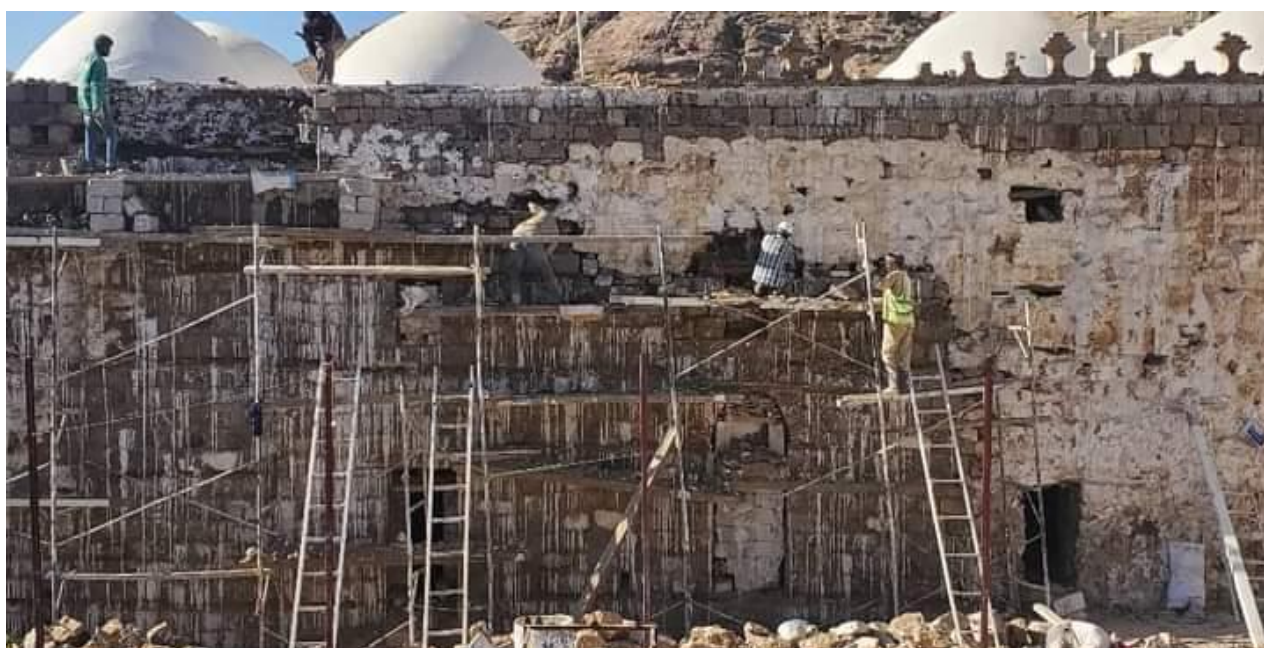
صورة 30: مناظر خارجية لأشغال ترميم المبنى.
