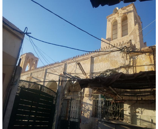
الصورة 37 : مدخل مسجد سيدي مسعود الجهة الجنوبية
