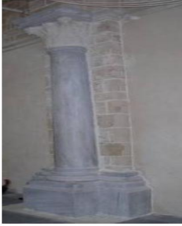
(ب): إزالة طبقة الخرسانة عن بدن العمود
