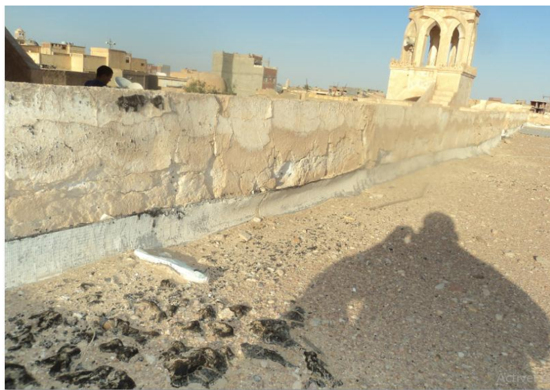
صورة 25 : تظهر طبقة الكتامة القديمة و تاكل جدار الحماية من الامطار
