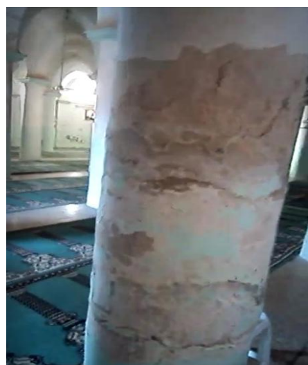
صورة 31 : تظهر تأثير الرطوبة على مستوى قواعد الاعمدة داخل قاعة الصلاة
