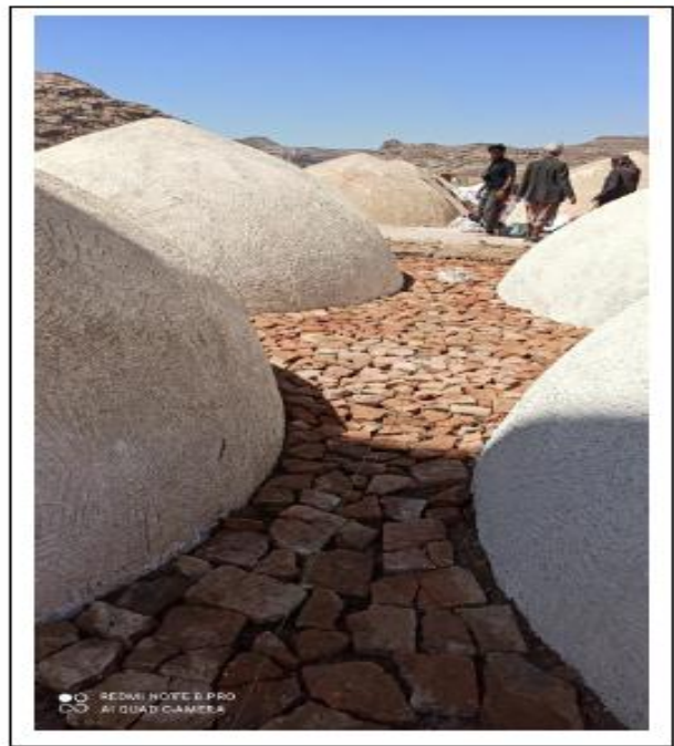
صورة 25: تحضير طبقات العزل لترميم السقف.
