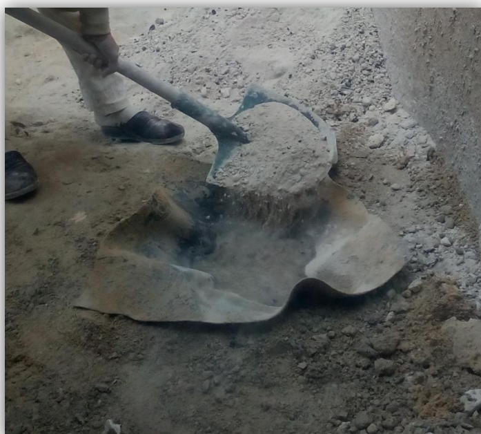
الصورة 11. القمطة المطاطية ( الشمبري ) المستعملة في عجن الجبس بالحي العتيق الاعشاش المصاعبة بالوادي
