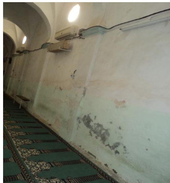
صورة 32 : تظهر تأثير الرطوبة على مستوى الجدار الخلفي لقاعة الصلاة
