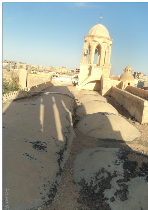
صورة 23 : تظهر تأثير الرطوبة على السقف الخارجي
