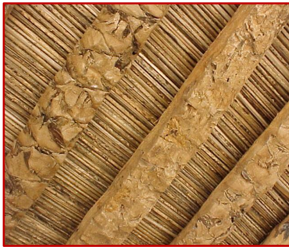
الصورة 8. استعمال جذوع النخيل في بناء الاسقف في بعض مناطق الوادي
