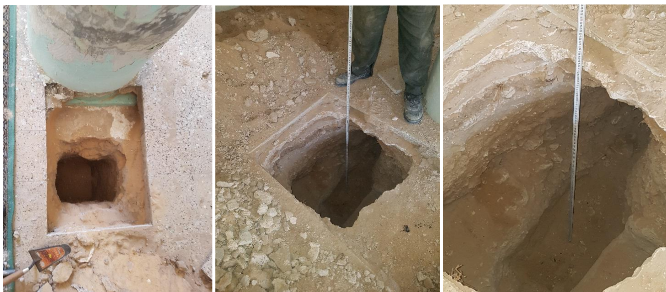
صورة 37 : تظهر تأثير الرطوبة على مستوى أرضية و أساسات المسجد
