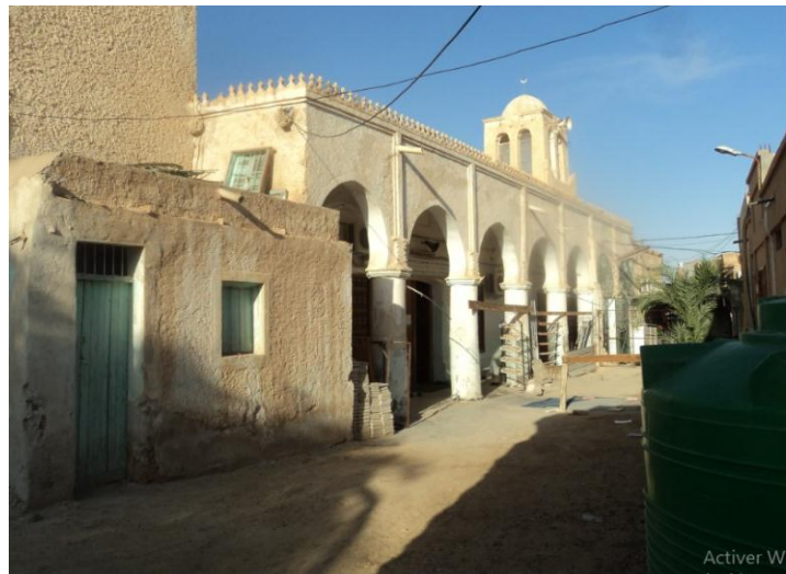
الصورة 38. الواجهة الجنوبية لمسجد سيدي مسعود
