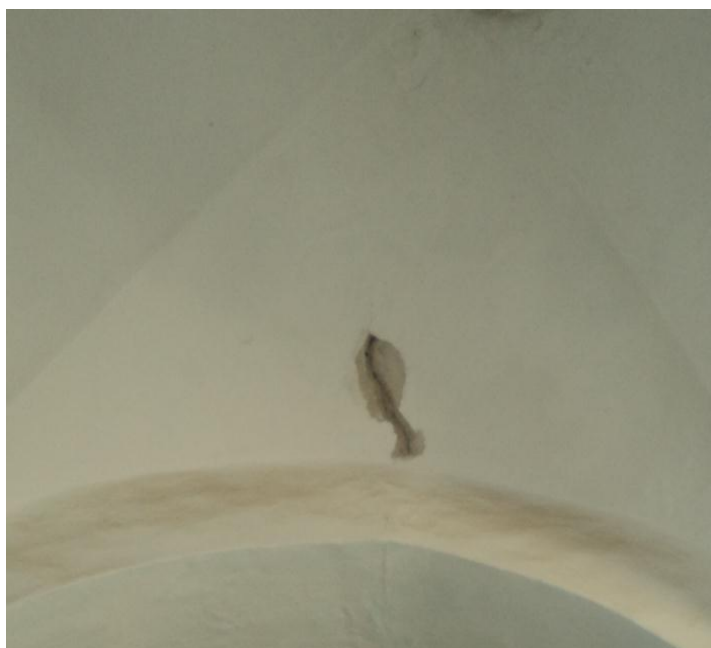
صورة 33 : تظهر تأثير الرطوبة على مستوى السقف الداخلي لقاعة الصلاة
