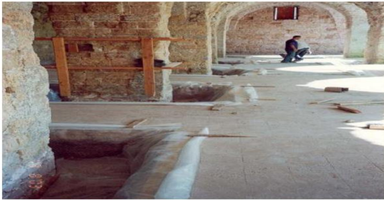
صورة 37: أعمال تنفيذ الخندق المحيط بالحوائط.
