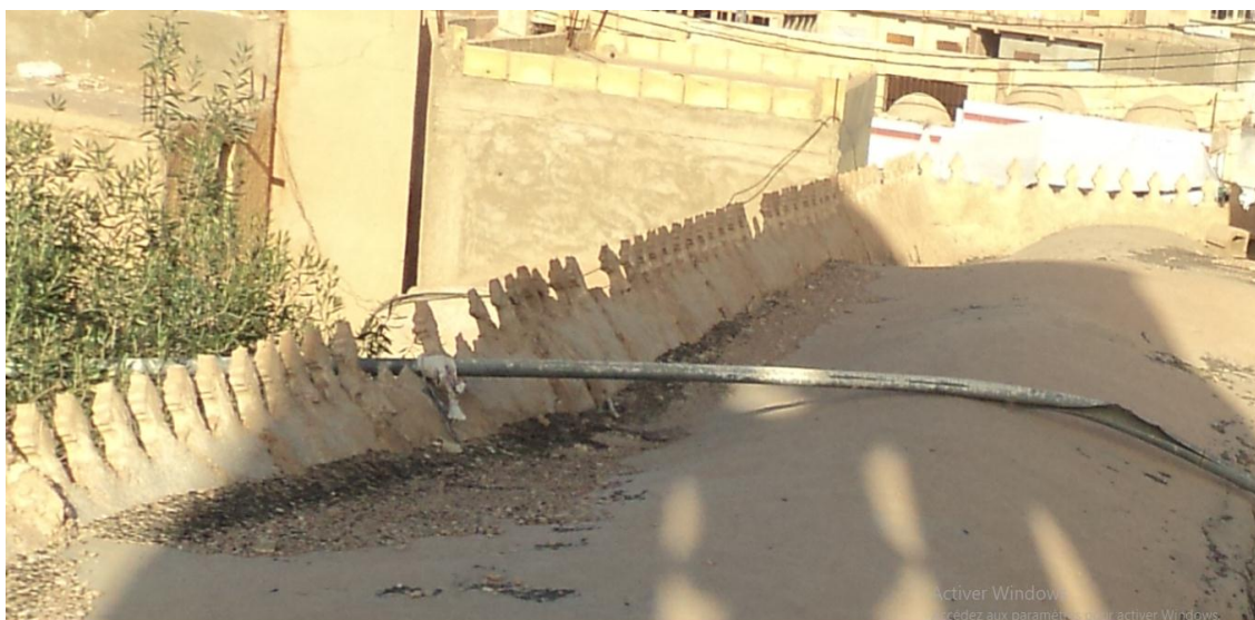
صورة 26 : تظهر تضرر عناصر الزخرفة و جوانب السقف
