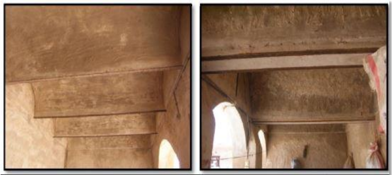
الصورة 9. طريقة استعمال الفولاذ في بناء الاسقف بالحي العتيق الاعشاش المصاعبة بالوادي
