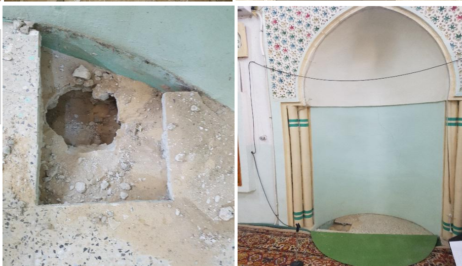
صورة 37 : تظهر تأثير الرطوبة على مستوى أرضية و أساسات المسجد
