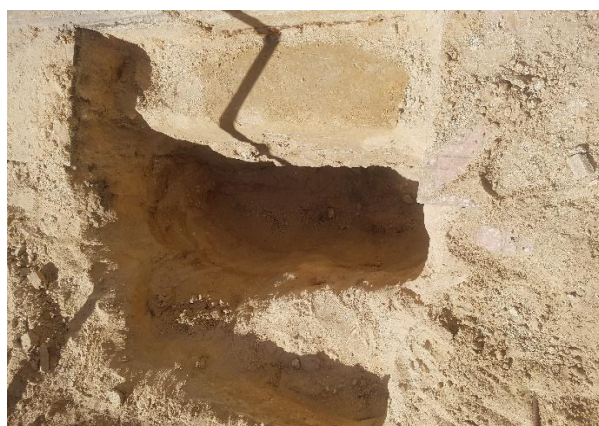
صورة 02 : تظهر تأثير الرطوبة على الاساسات بعد الحفر
