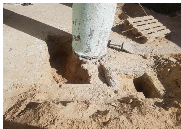
صورة 02 : تظهر تأثير الرطوبة على الاساسات بعد الحفر
