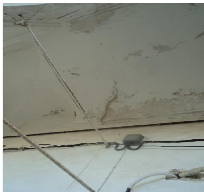
صورة 22 : تظهر تأثير الرطوبة على الجدران و السقف و تأكلها
