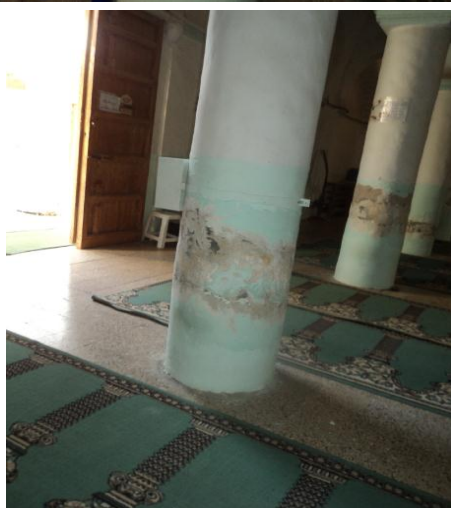
صورة 29 : تظهر تأثير الرطوبة على الاعمدة داخل قاعة الصلاة
