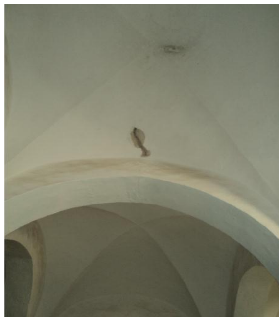
صورة 33 : تظهر تأثير الرطوبة على مستوى السقف الداخلي لقاعة الصلاة
