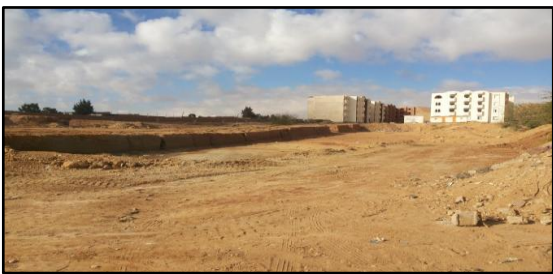
Figure III.26 : Vue de profil sur le site d'intervention Source : Auteur
