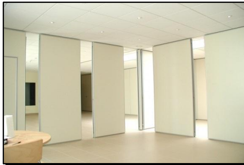
Figure .8 : Les parois mobile. Source : http://linconyl.com/16-interieur
