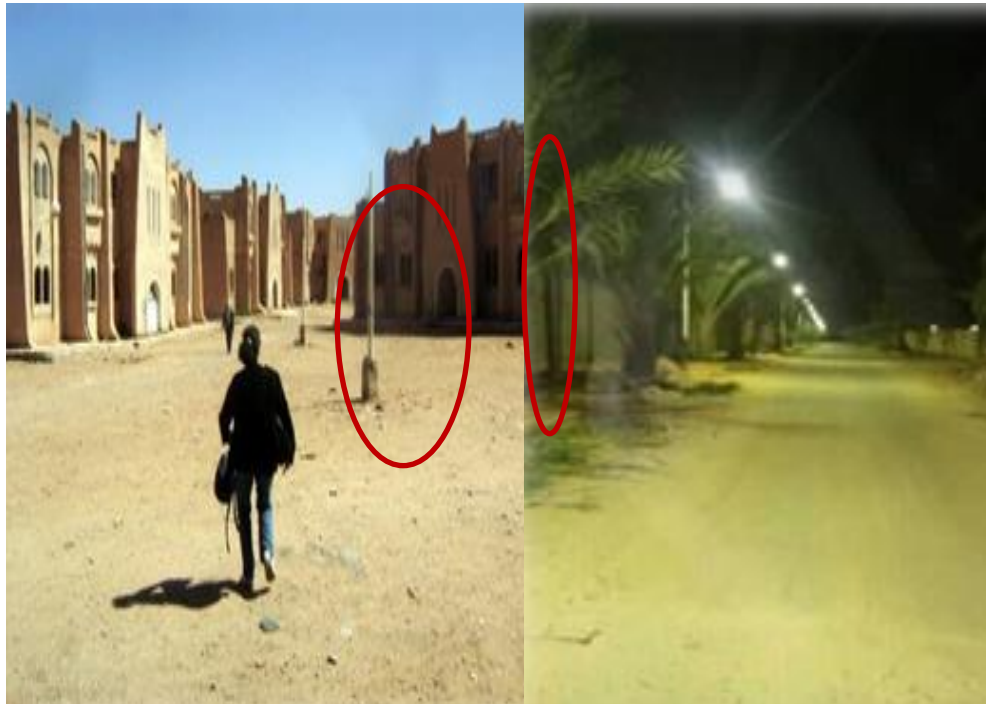
Figure N°77 : état des éléments d'éclairage public d'éclairage public Dans la ville de Zelfana
