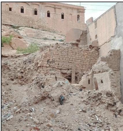
FigIII.8 : maison à reconstruire (source auteurs)
