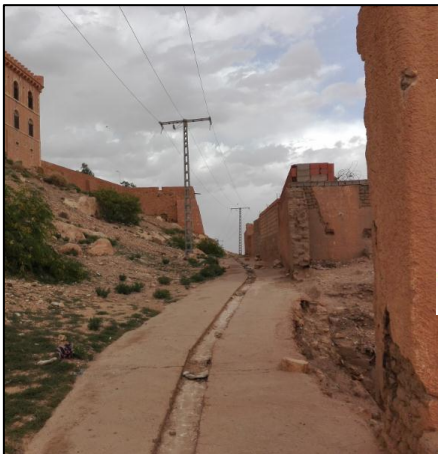
FigIII.2 : l'ancienne voie piétonne (source auteurs)
