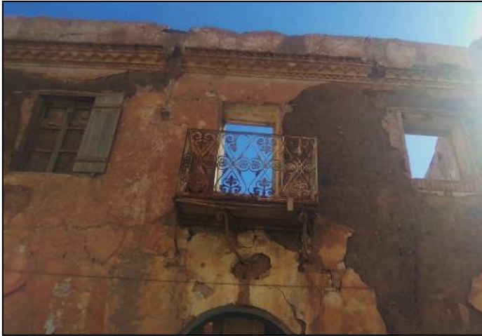
Fig II.22 : les balcons ajoutés à zrag el-hedjaj durant la période coloniale, (source : auteurs)
