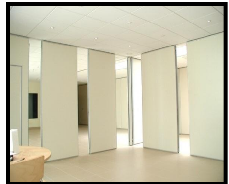
Fig VIII.4. Exemple d'un mur intérieur mobile Source : Google. Image
