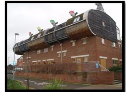
Figure III.13 : façade BDZ (la source : Google image)
