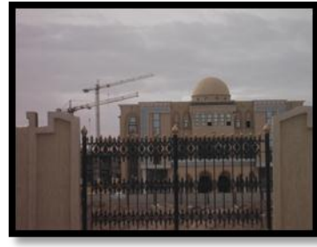
Figure IV .17 : le nouveau siège de wilaya Source : auteur
