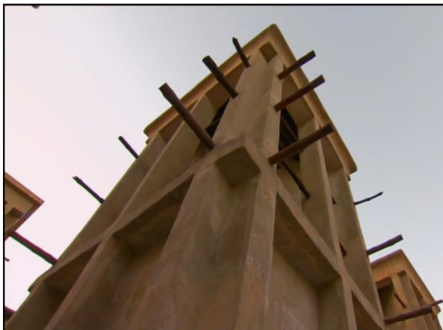
Fig1. La tour à vent traditionnelle
