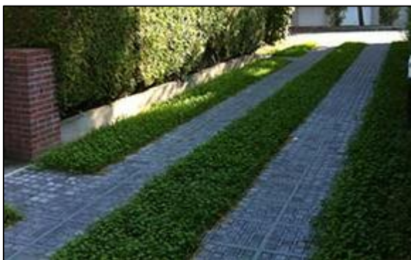
Fig1. Schema d'un parking perméable
