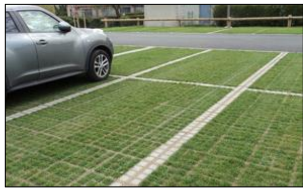
Fig1. Schema d'un parking perméable
