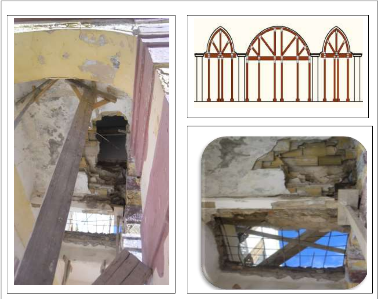
Figure 30: consolidation des arcs et voutes avec des étaieiments en bois et en métal, (source: auteur 2020)
