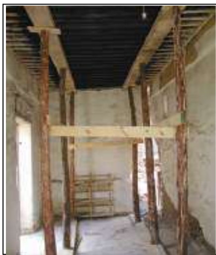
Figure 39 : Étais en bois brut, (source: https://www.cmimarseille.org , Pathologie des bâtiments traditionnels dans le contexte spécifique des médinas marocaines, guide de référence).
