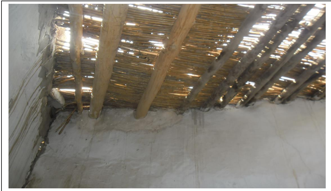
Vue sur le plancher traditionnel de la deuxième habitation (irrégularité des solives)
