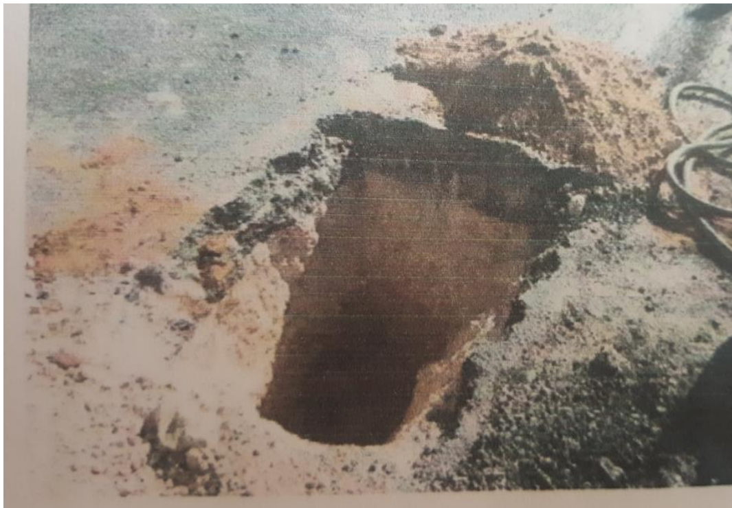
Figure II.16: Le sondage sous chaussée .
