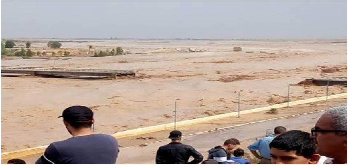
Figure II.4: La crue centennale de Oued M'zi et l'effondrement du pont de Sidi Hakoum[33].
