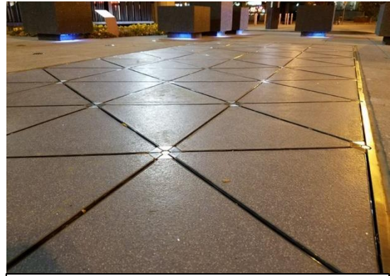
Figure 173 : Revêtements piézoélectriques Source : https://drprem.com
