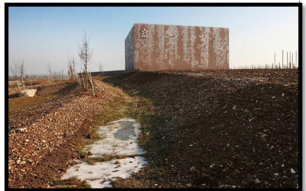
Figure III-13 Centre d'archive EDF (Source : Archdaily.com)
