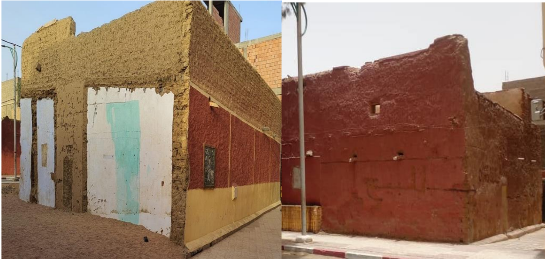
Figure IV.15 : Vue sur les bâtisses en Toub (source : auteur).
