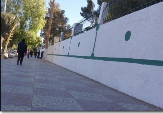
الشكل 99 : صورة لواجهة تكتة الدرك الوطني بشارع الاستقلال بالأغواط ملتقطه من طرف الطالب
